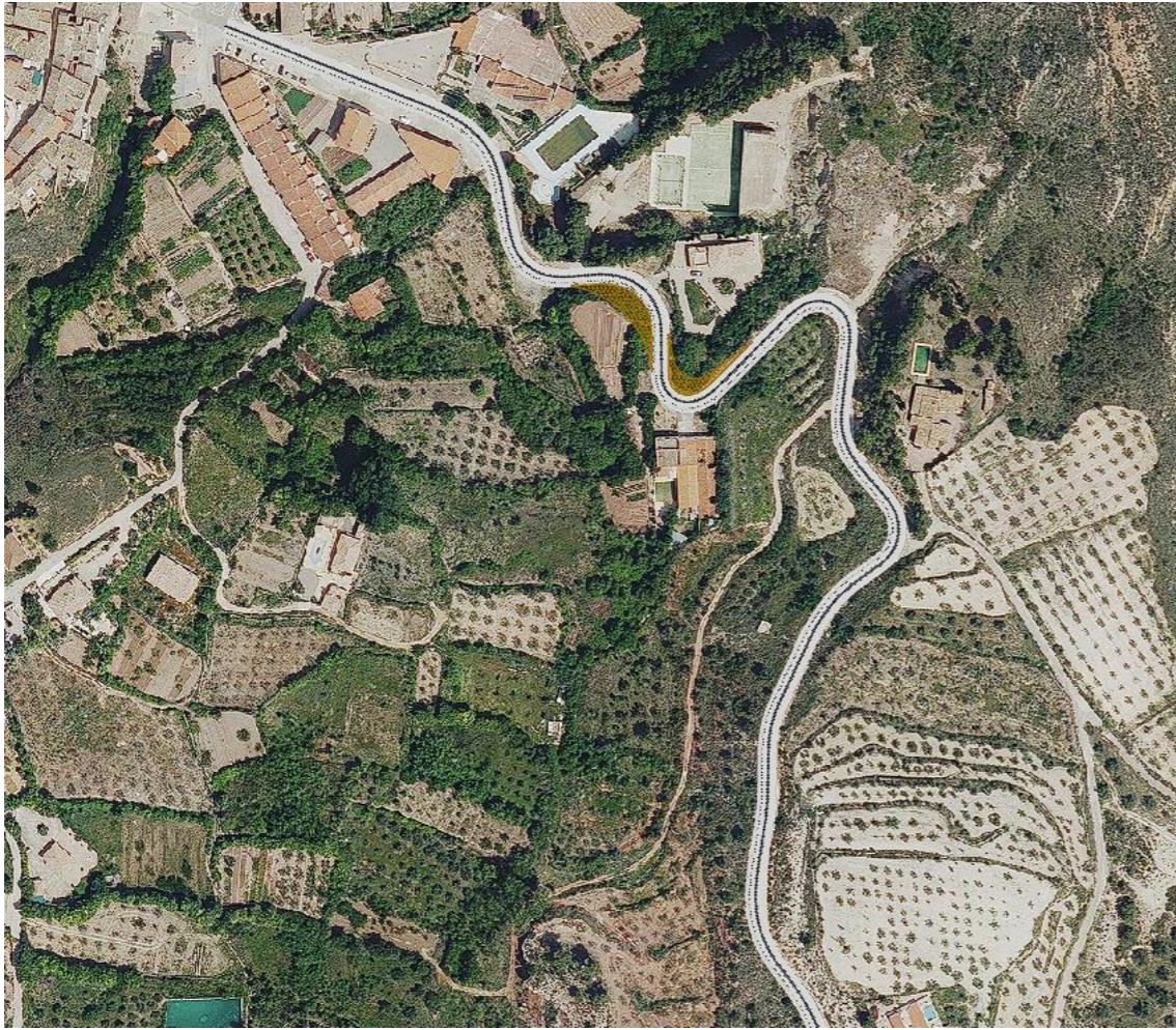
Figura 4. Acondicionamiento Zona limitada Tramo I (PK 2+370 - PK 3+133). Fuente: Elaboración propia.
