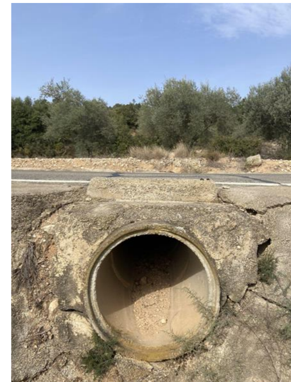
Figura 10. Obra de drenaje transversal (ODT), Tramo I PK 0+390. Fuente: Elaboración propia.
