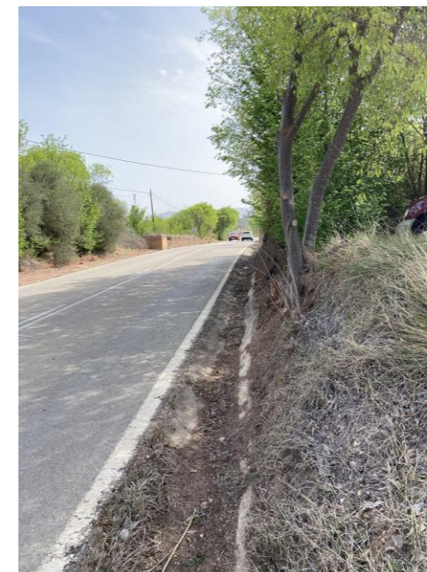
Figura 13. Cuneta triangular. Fuente: Elaboración propia.
