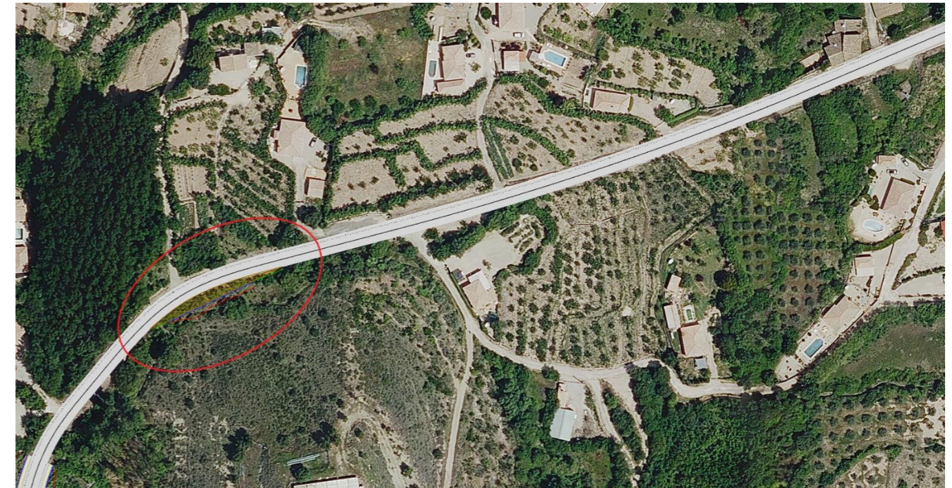
Figura 7. Acondicionamiento Zona limitada Tramo II (PK 0+568 - PK 0+659). Fuente: Elaboración propia
