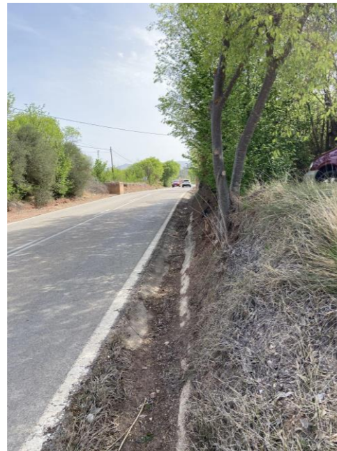
Figura 12. Cuneta triangular. Fuente: Elaboración propia.
