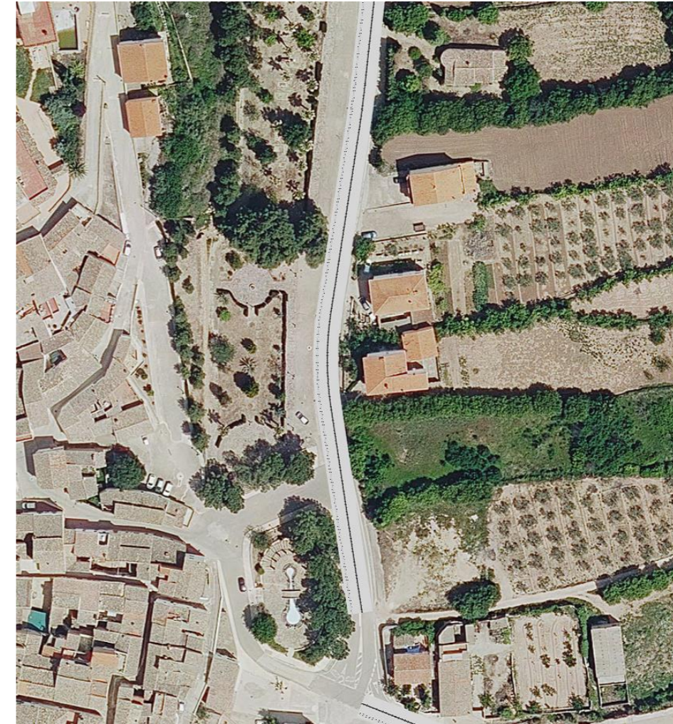
Figura 5. Acondicionamiento Zona limitada Tramo II (PK 0+000 - PK 0+181). Fuente: Elaboración propia.
