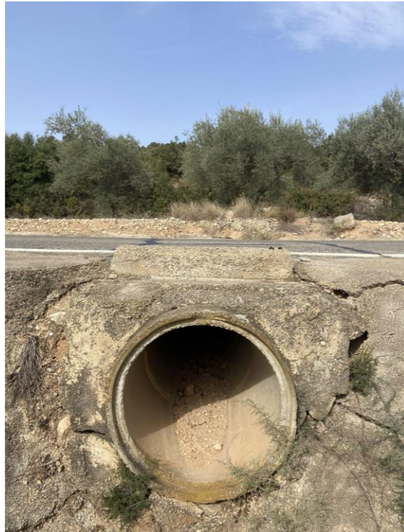
Figura 11. Obra de drenaje transversal (ODT), Tramo I PK 0+390. Fuente: Elaboración propia.
