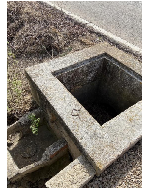
Figura 12. Obra de drenaje, Tramo II PK 0+780. Fuente: Elaboración propia.
