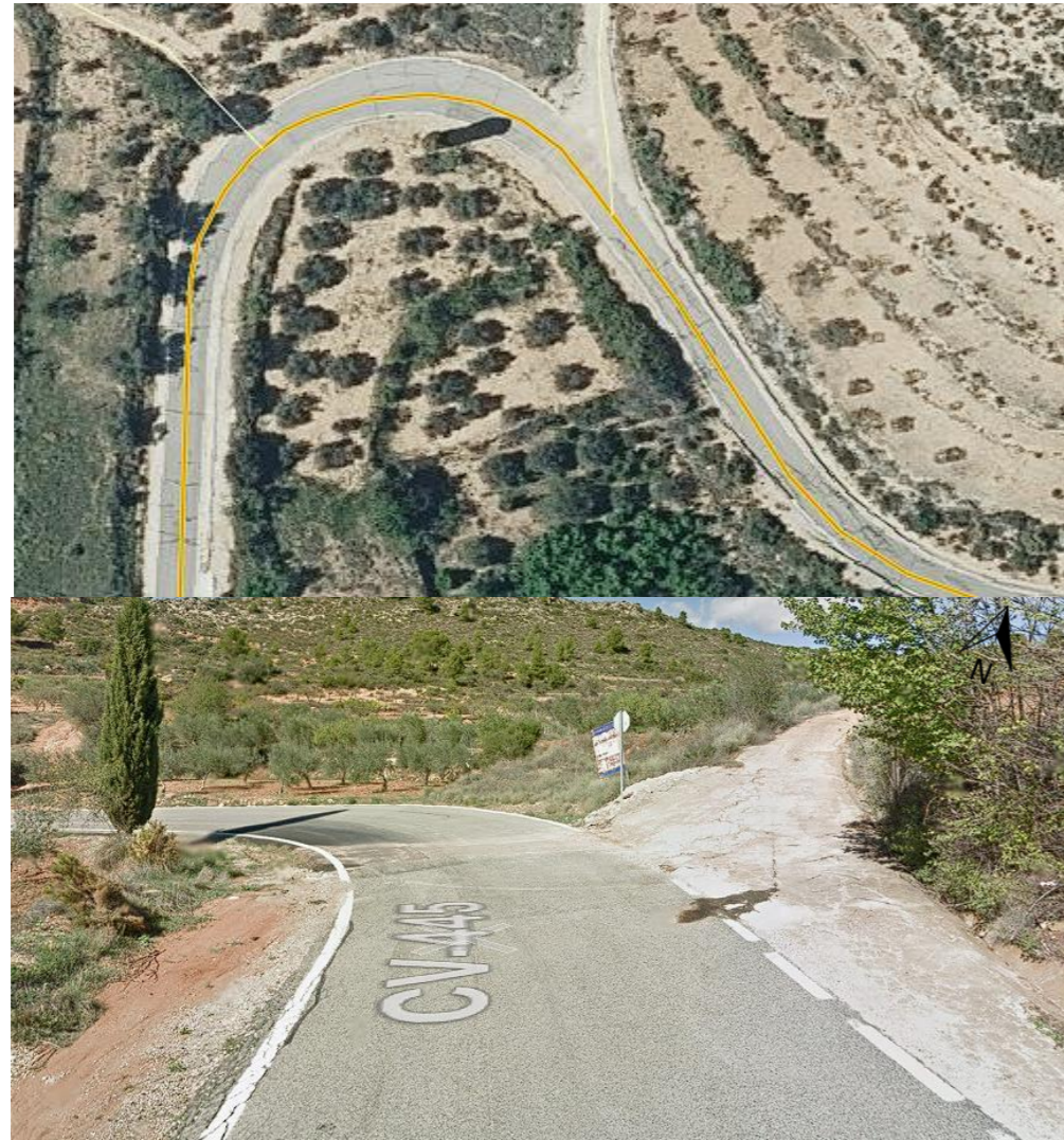
Figura 4. Acceso a camino y viviendas privadas (PK 0+540). Fuente: Elaboración propia.
