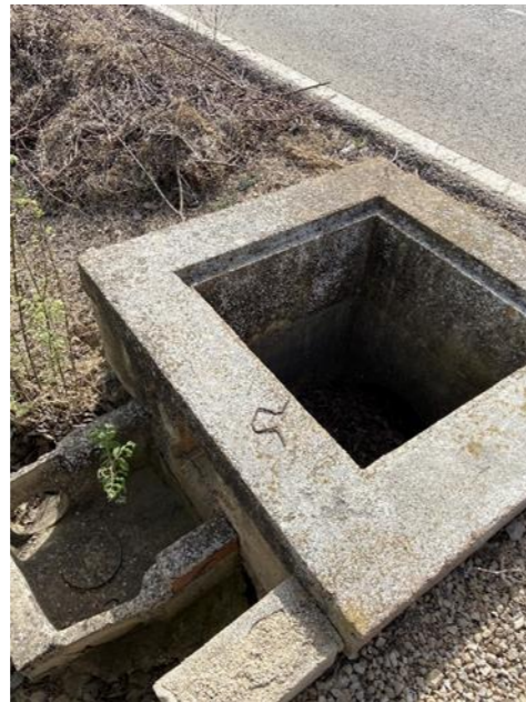
Figura 11. Obra de drenaje, Tramo II PK 0+780 .Fuente: Elaboración propia.
