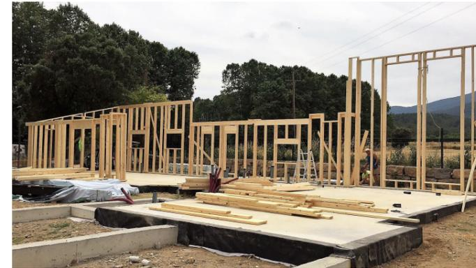
Entramado de madera sobre durmientes de hormigón
