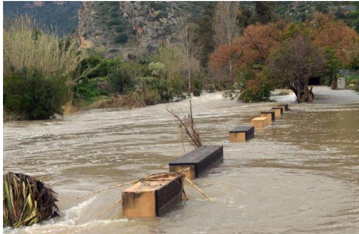
Imagen 31:Entrada en carga de un puente ( www.levante-emv.com )
