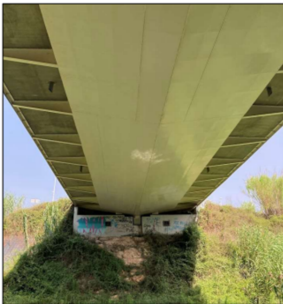
Fotografía 3, Vista inferior de la plataforma
