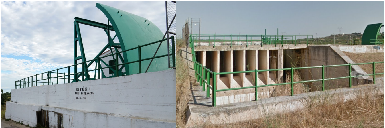
Imágenes 41 y 42: Compuertas de sifón y aliviadero del canal (Fuente propia)
