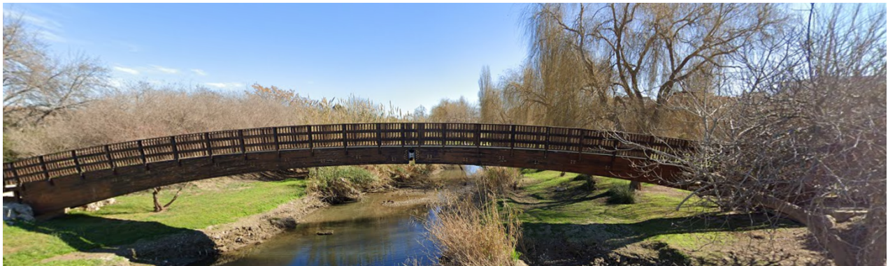
Imagen 68: Pasarela peatonal en el municipio de Quart de Poblet (Fuente propia)
