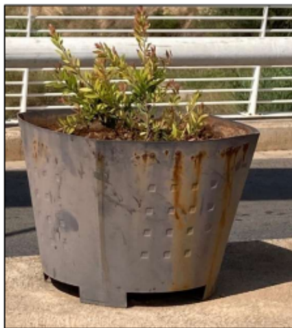
Fotografía 22, Corrosión en jardineras
