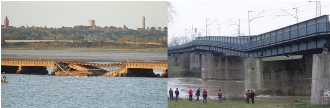
Imagen 19: De izquierda a derecha, imágenes del colapso del viaducto Malahide y del puente Sava ( www.idvia.es )
