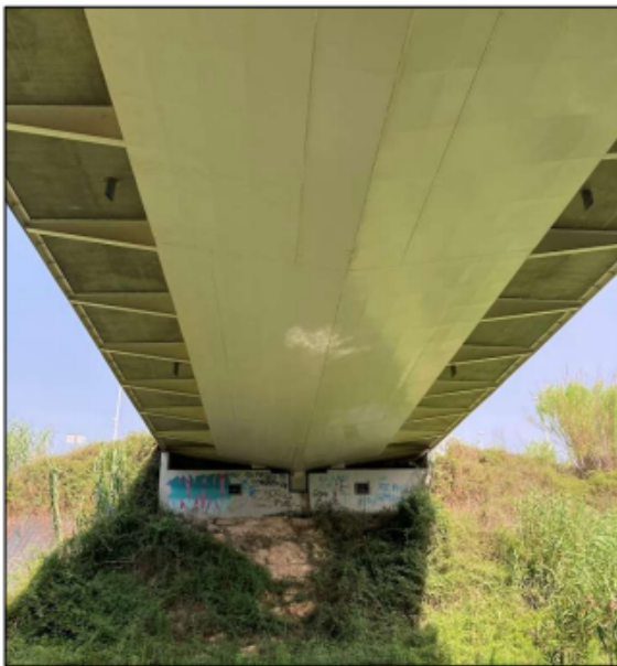
Fotografía 3, Vista inferior de la plataforma
