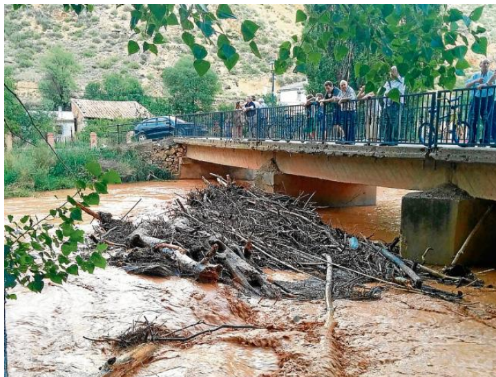
Imagen 30: Obstrucción del vano por el material flotante ( www.heraldo.es )
