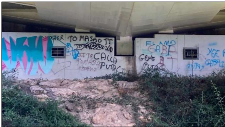
Fotografía 30, Pinturas en estribos
