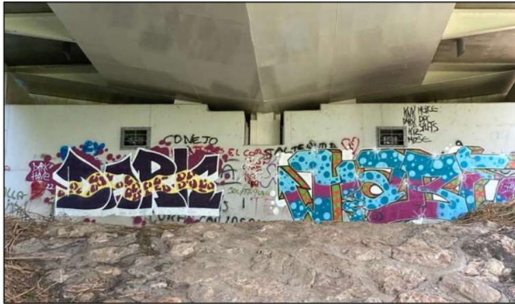
Fotografía 29, Pinturas en estribos
