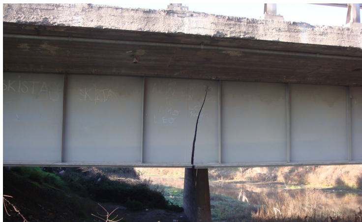
Imagen 52: Fisura por fatiga ( infobasicingcivil.blogspot.com )
