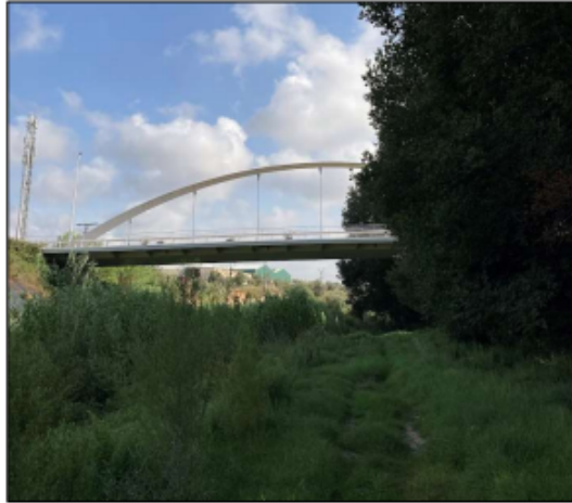
Fotografía 1: General del puente junto al cauce
