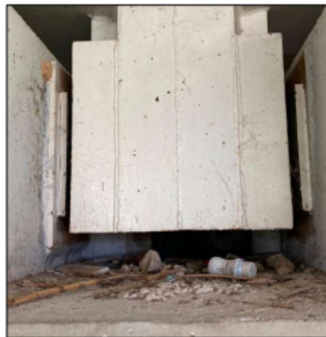
Fotografía 23, Residuos en estribos
