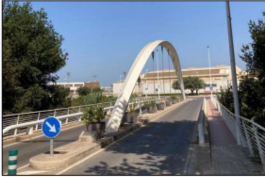
Fotografía 1, Vista general del puente
