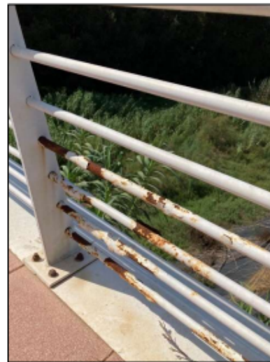
Fotografía 4, Corrosión barandillas
