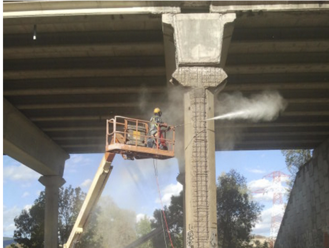
Imagen 17: Tareas de mantenimiento en las pilas de un puente (Tecyrsa)
