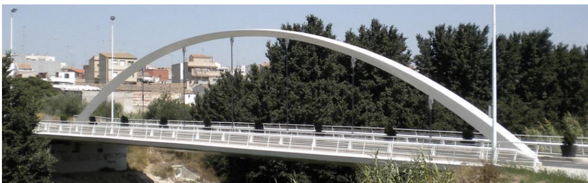
Imagen 45: Puente de la Avenida del Sur (Fuente propia)
