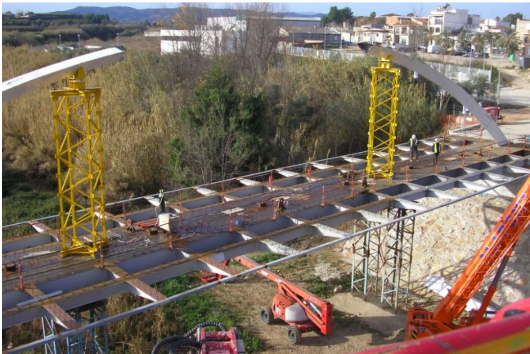
Imagen 58: Fotografía del momento del izado del arco ( www.hortacoslada.com )
