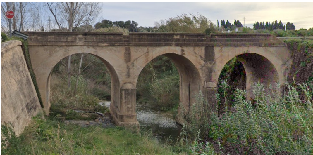
Imagen 44: Puente de Fonde de l'Omet (Fuente propia)
