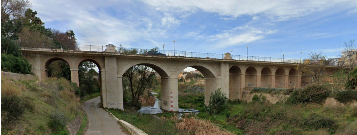
Imagen 46: Puente de la entrada de Picassent (Fuente propia)
