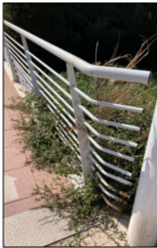
Fotografía 20, Vegetación en plataforma
