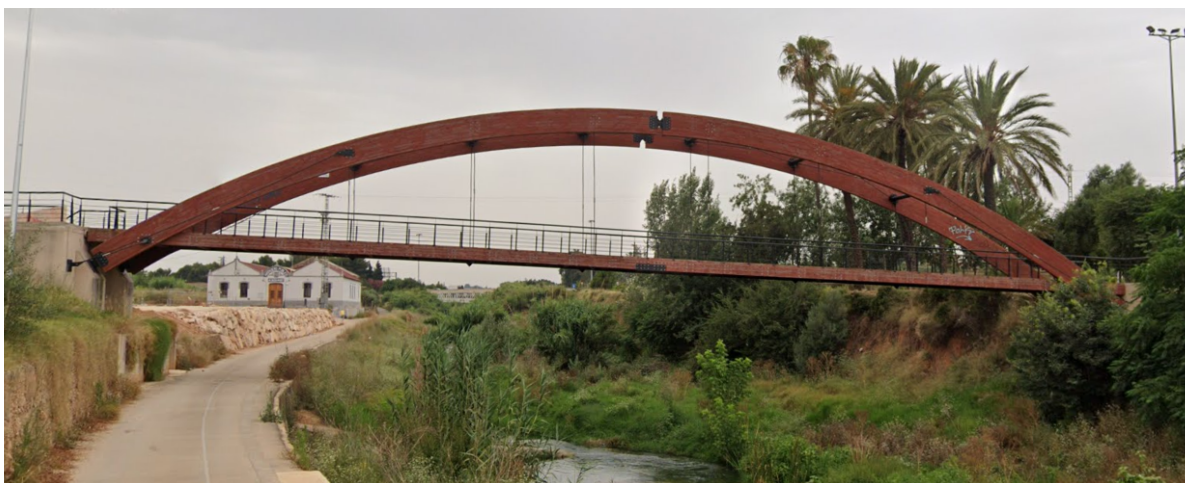
Imagen 66: Pasarela peatonal sobre el barranco de Picassent en la localidad de Alcácer (Fuente propia)
