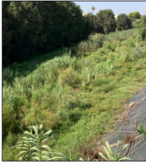
Fotografía 24, Obstrucción del barranco por la vegetación
