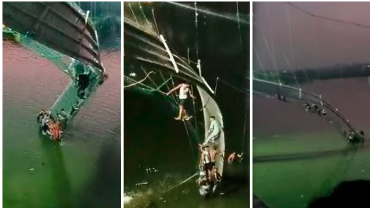
Imagen 24: Imágenes momentos después del colapso ( www.grupovx.com )
