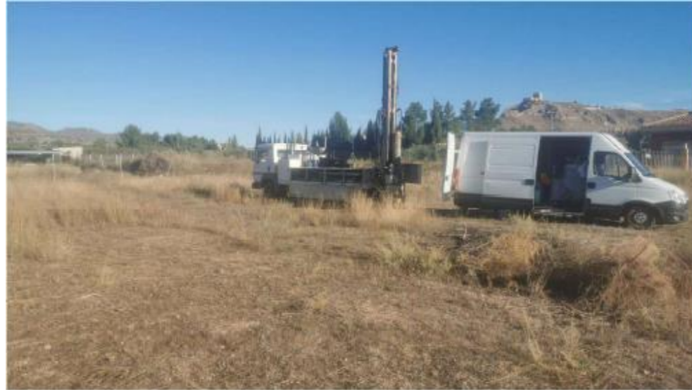
Imagen 3. Realización del sondeo S1 (Fuente: Informe geotécnico G-3187)
