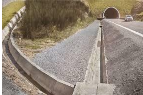
ILUSTRACIÓN 7: CUNETA CON COLECTOR (FUENTE: GOOGLE IMAGES)
