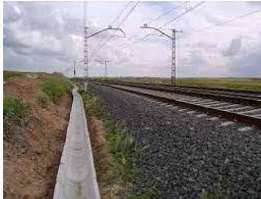
ILUSTRACIÓN 6: CUNETA (FUENTE: GOOGLE IMAGES)
