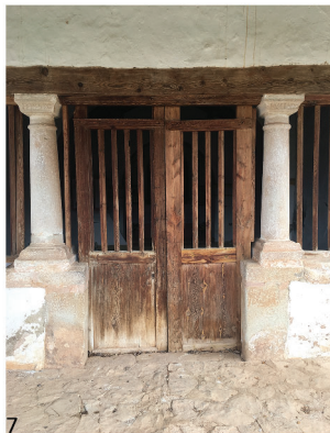
ACCESO A LA NAVE
