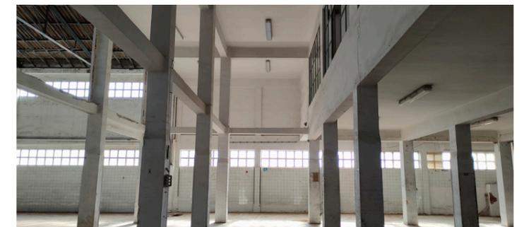
Pórticos con necesidad de refuerzo - menor canto de viga por no existir forjado en el estado existente de la estructura
