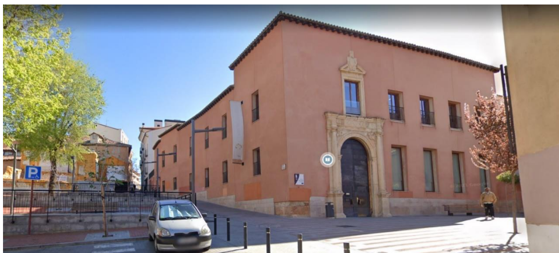
ILUSTRACIÓN 33: ACCESO Y ENTORNO DE LA BIBLIOTECA
