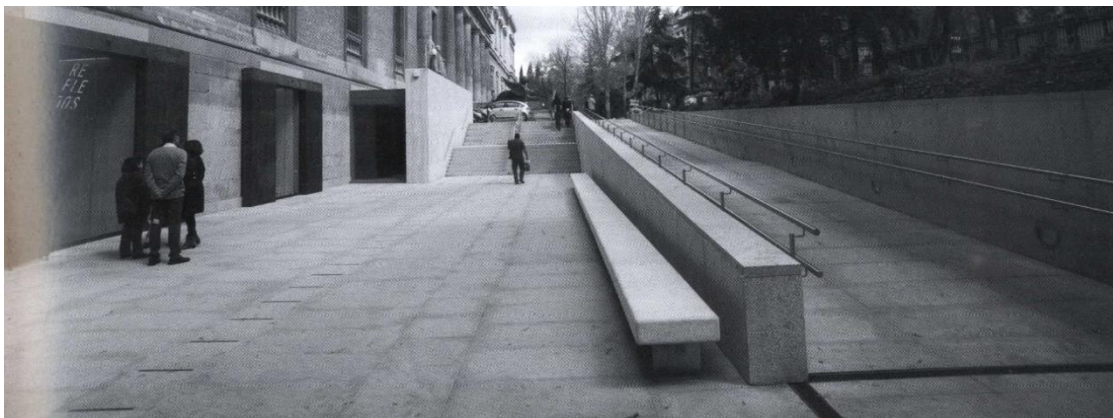
ILUSTRACIÓN 12: RAMPA Y ESCALERA DE ACCESO AL MUSEO Fuente: La intervención en el patrimonio y el proyecto de accesibilidad
