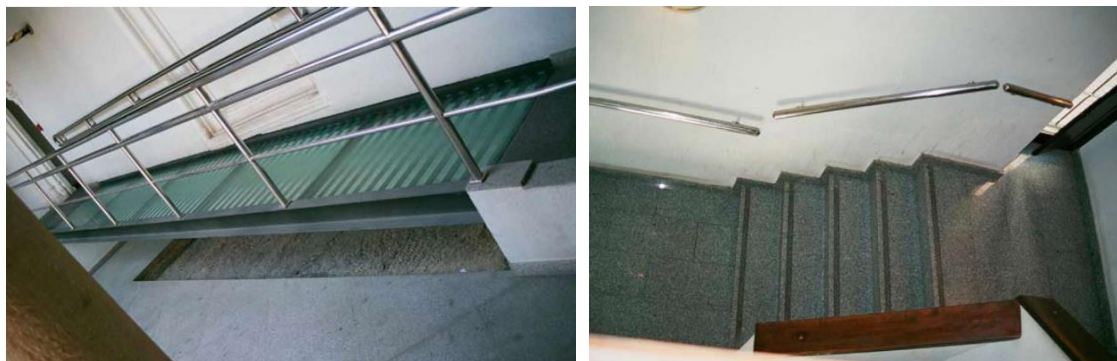
ILUSTRACIÓN 28: RAMPA DE ESCALERA INTERIOR Fuente: Buenas Prácticas en Accesibilidad Universal
