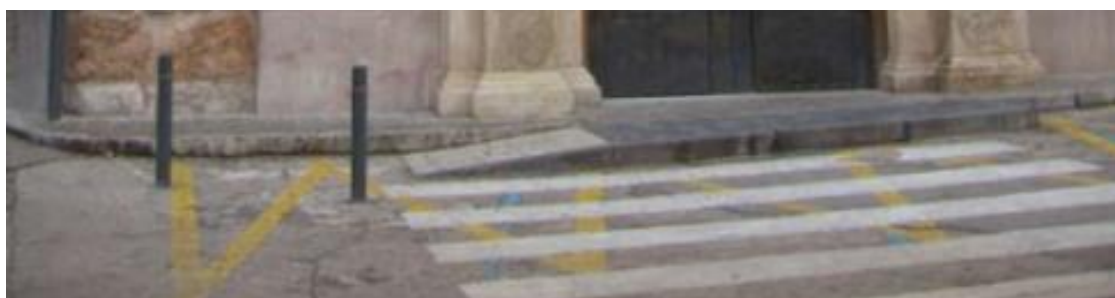
ILUSTRACIÓN 34: ANTIGUA RAMPA DE ACCESO PROTEGIDA CON BOLARDOS
