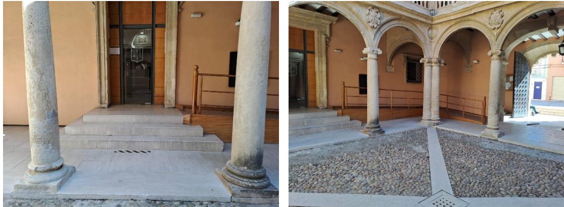
ILUSTRACIÓN 76: RAMPA Y ESCALONES DE ACCESO A LA ZONA ADMINISTRATIVA Fuente: fotografías propias
