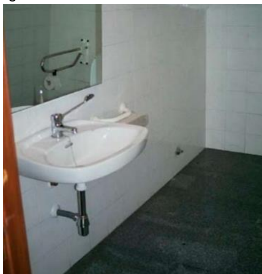
ILUSTRACIÓN 31: LAVABO, GRIFERÍA Y PICAPORTE DEL ASEO ACCESIBLE
