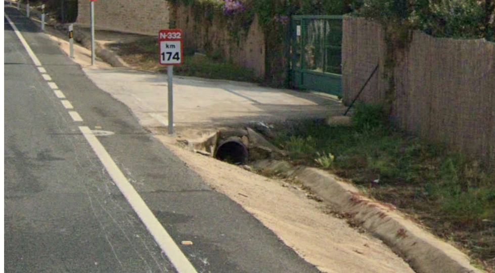
Figura 6. Paso salvacuneta en el p.k. 174 del tramo de estudio (Fuente: Elaboración propia)
