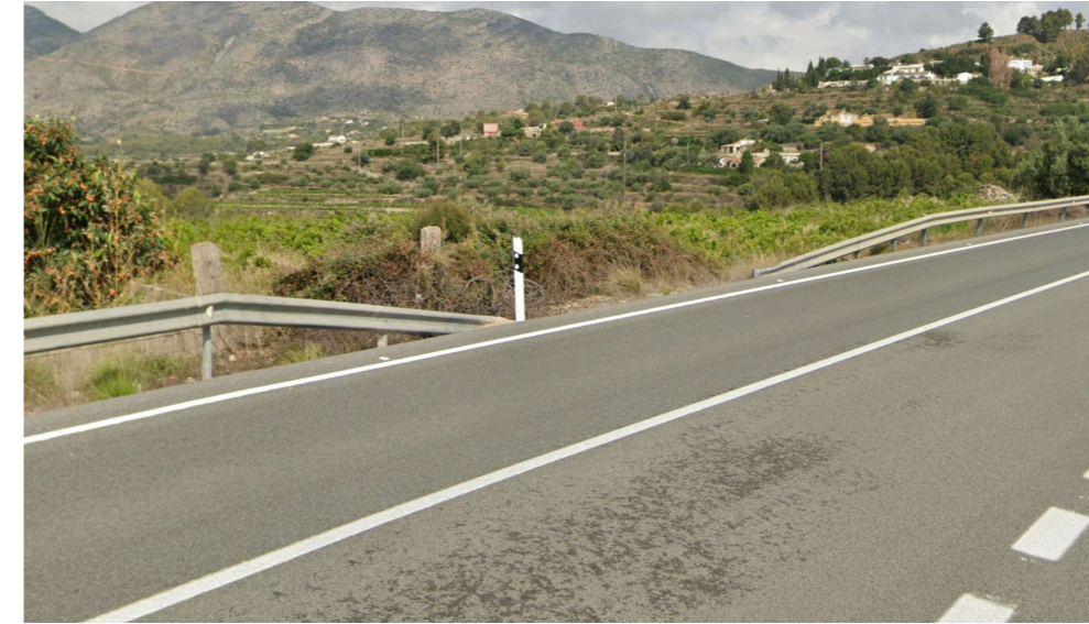
Figura 8. Separación incorrecta de barreras de seguridad entre el p.k. 174+785 y el p.k. 174+809 (Fuente: Elaboración propia)
