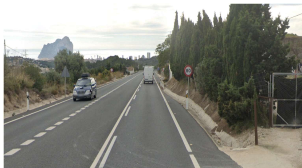
Figura 7. Señal R-301 en el p.k. 173+747 del tramo de estudio (Fuente: Elaboración propia)
