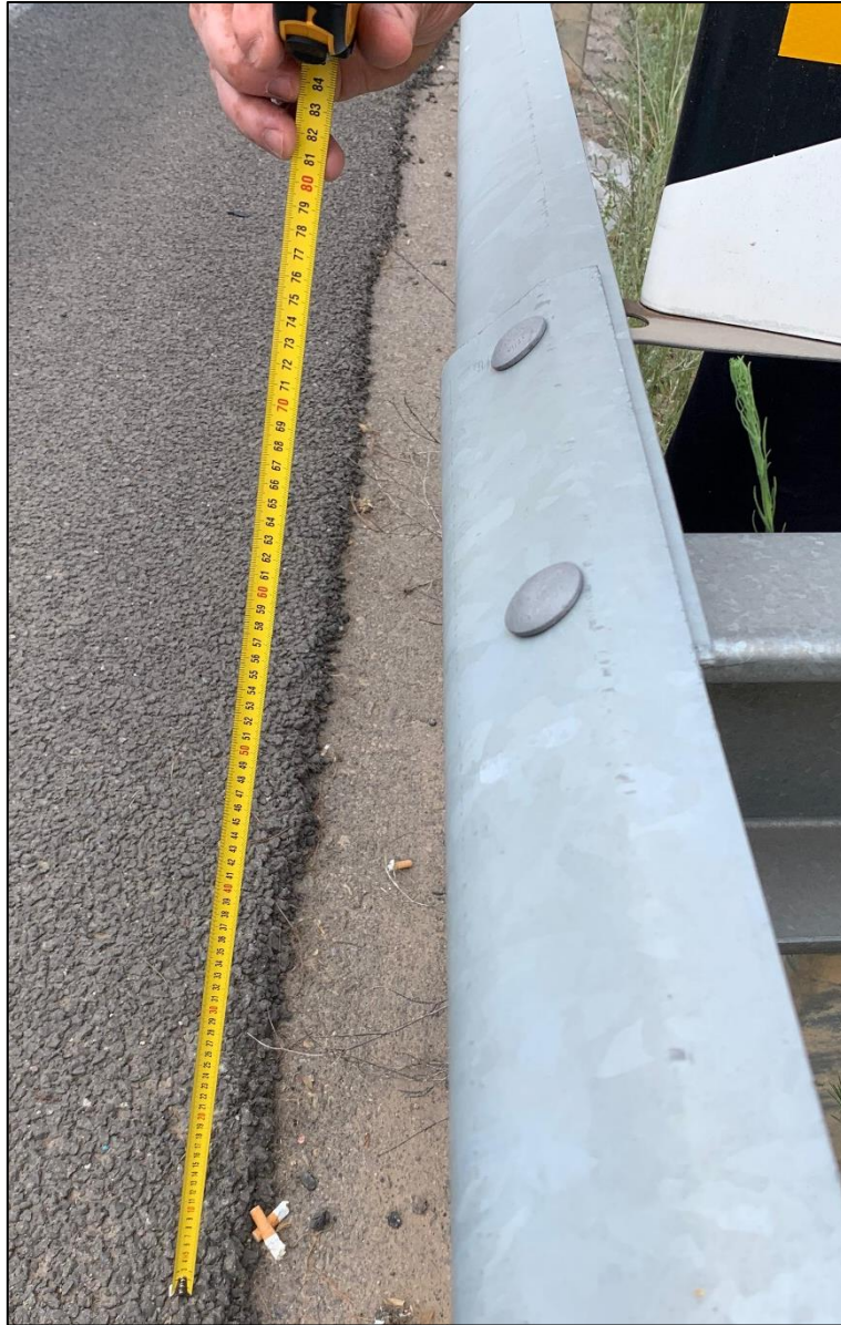
Figura 4. Altura de la barrera metálica en el PK 0+750 ascendente.
