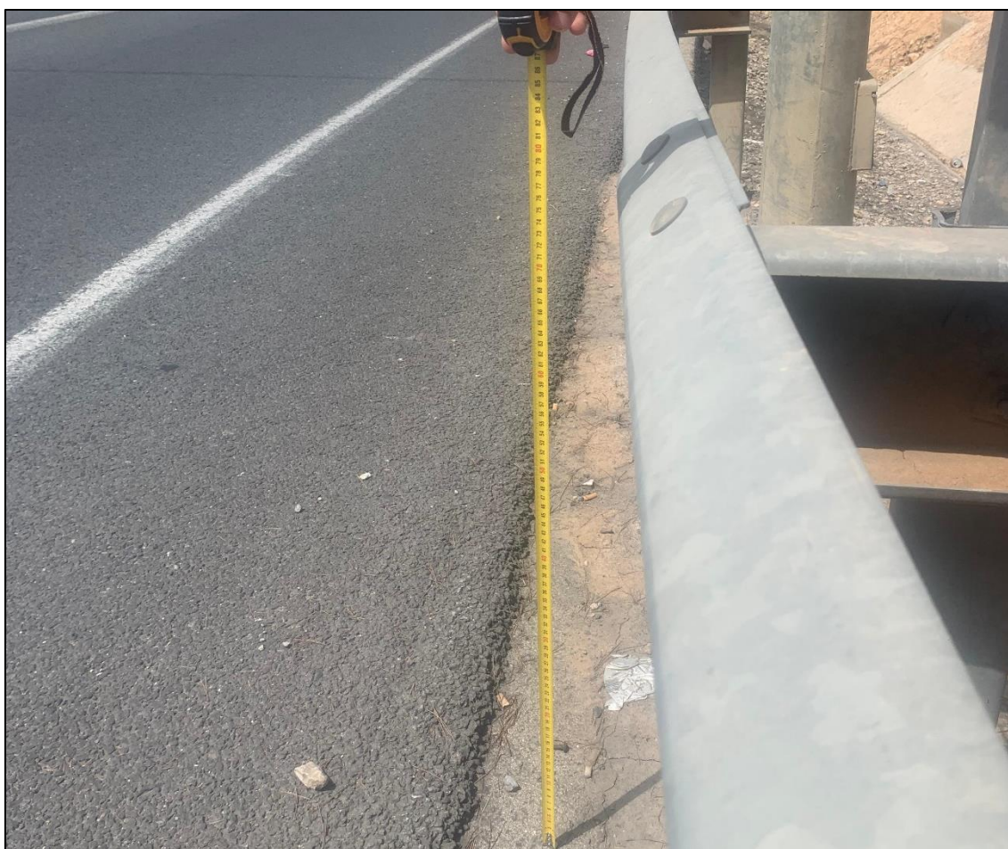
Figura 108. Altura de la barrera de metálica suficiente en el PK 0+550 en sentido ascendente. (80cm)
