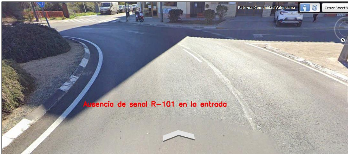
Figura 153. Ausencia de señal R-101 en el carril de entrada O
