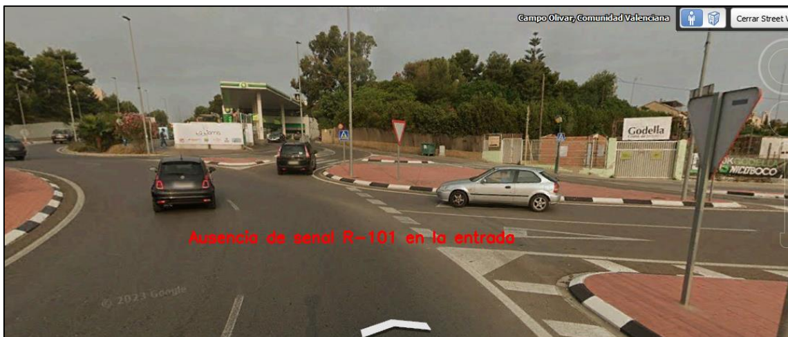
Figura 170. Ausencia de señal R-101 en el carril de entrada N
