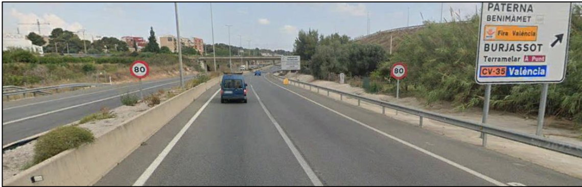
Figura 72. Limitación de velocidad de 80 km/h en el PK 0+510 en sentido ascendente.
