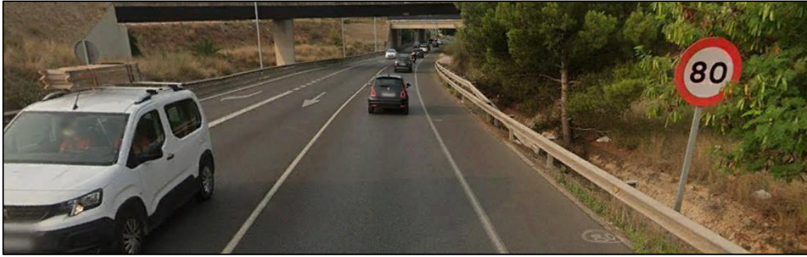
Figura 75. Limitación de velocidad de 80 km/h en el PK 3+520 en sentido descendente.
