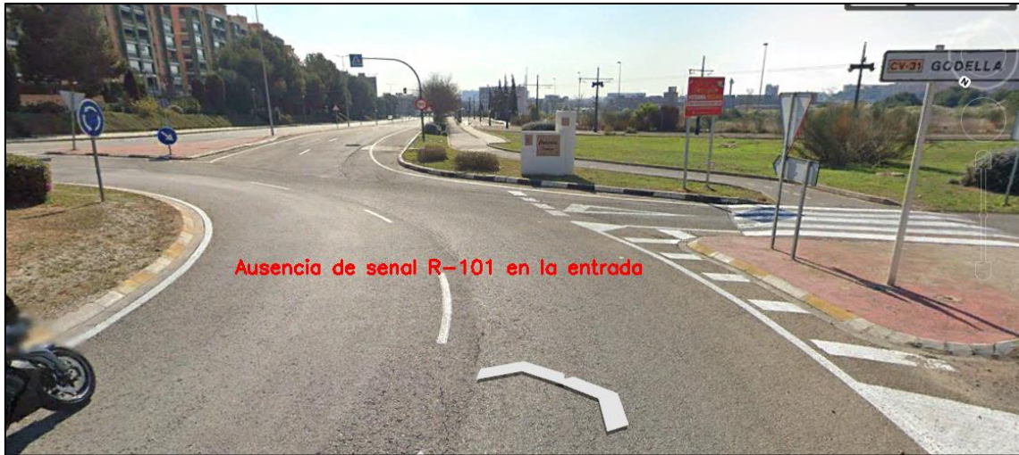
Figura 162. Ausencia de señal R-101 en el carril de entrada SO
