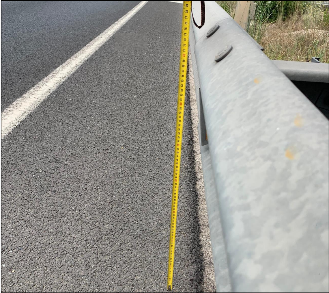
Figura 119. Altura suficiente de la barrera metálica en el PK 0+900 en sentido ascendente (79cm)
