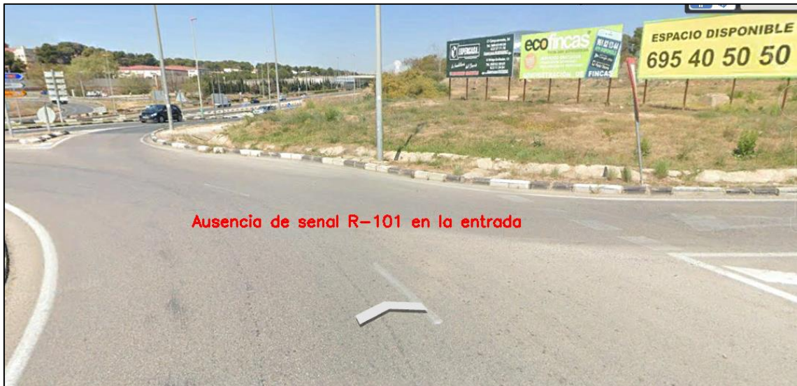
Figura 150. Ausencia de señal R-101 en el carril de entrada NE
