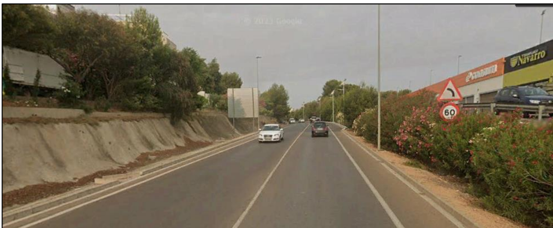
Figura 74. Limitación de velocidad de 60 km/h en el PK 4+120 en sentido descendente.
