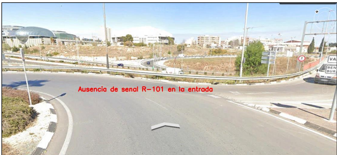
Figura 155. Ausencia de señal R-101 en el carril de entrada E
