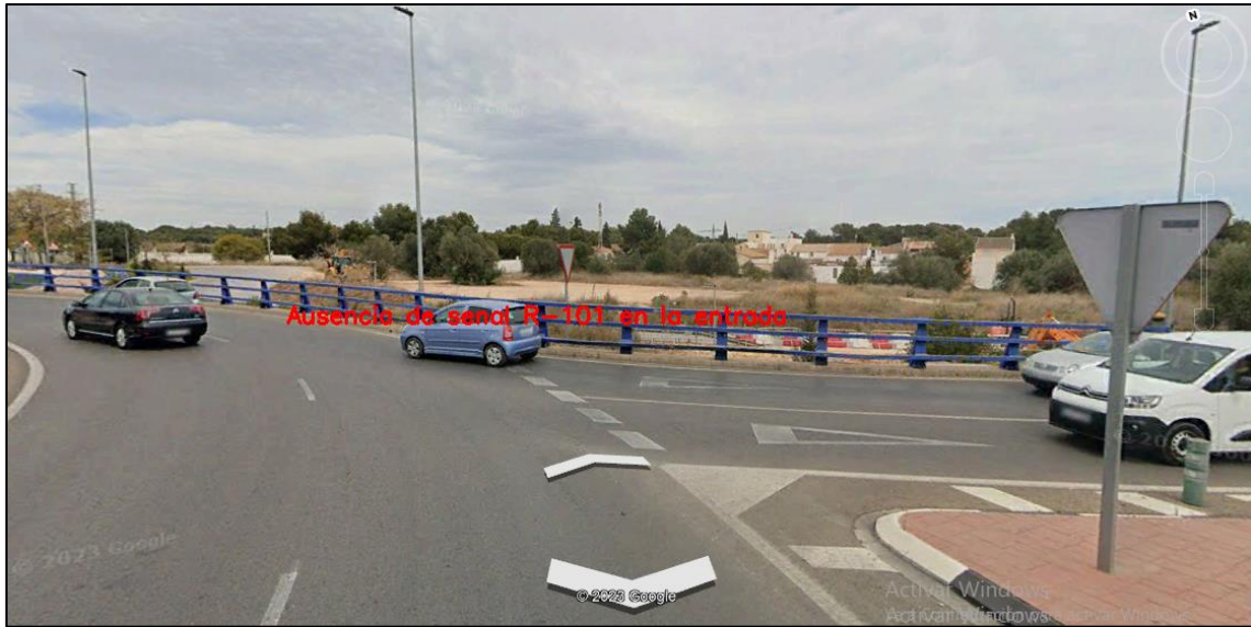
Figura 169. Ausencia de señal R-101 en el carril de entrada E
