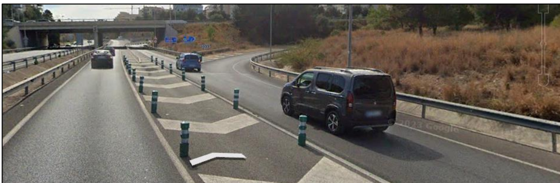
Figura 91. Fotografía de la sección transversal de la carretera en el PK 2+750, sentido descendente
