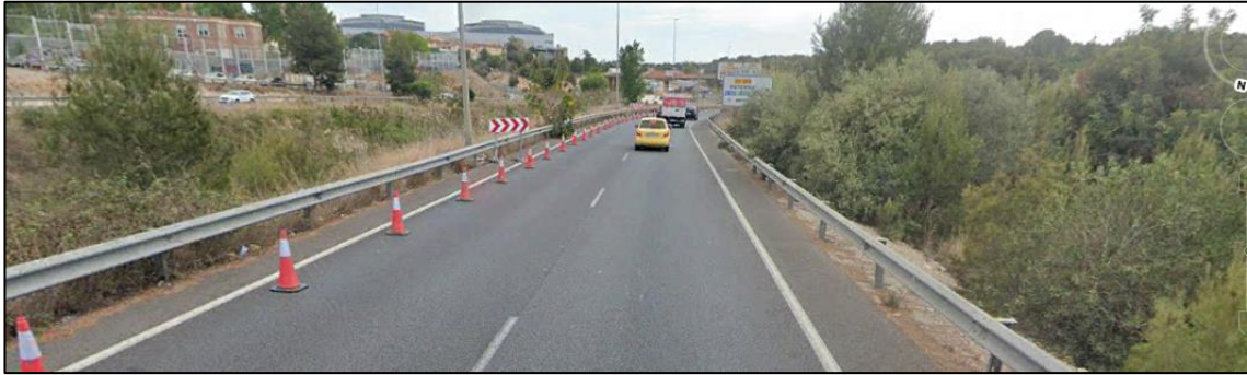
Figura 89. Fotografía de la sección transversal de la carretera en el PK 2+450, sentido descendente
