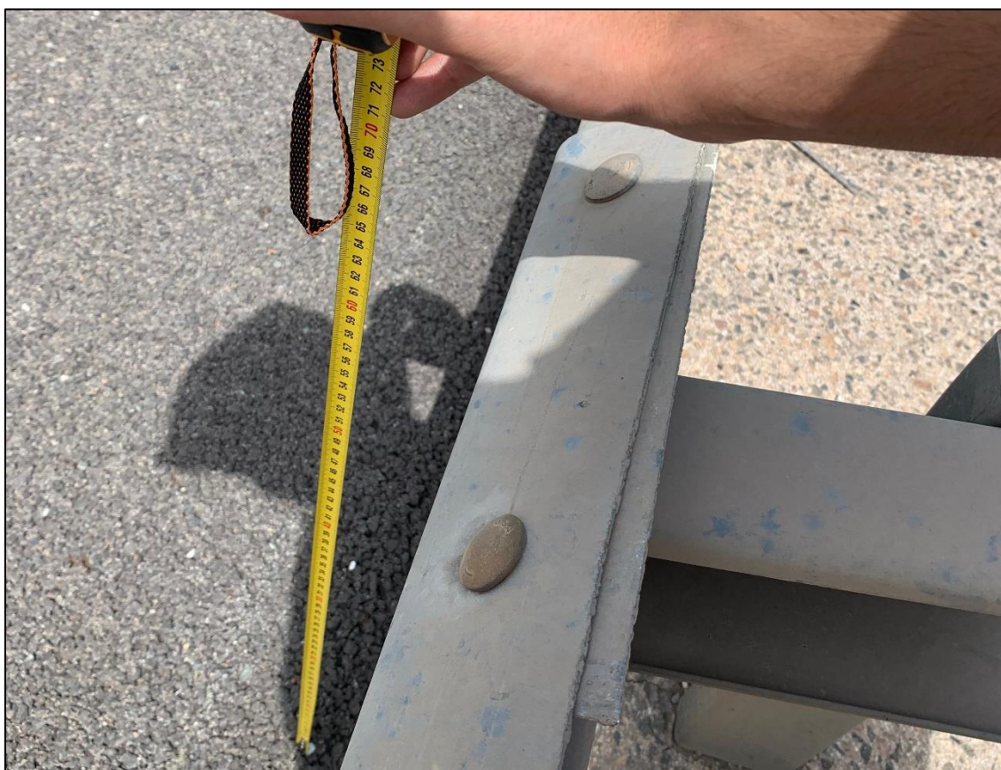
Figura 128. Altura suficiente de la barrera metálica en el PK 3+000 en sentido ascendente (75cm)
