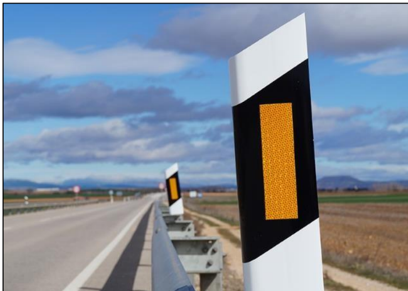
Figura 36. Hito de arista adosado a barrera metálica
