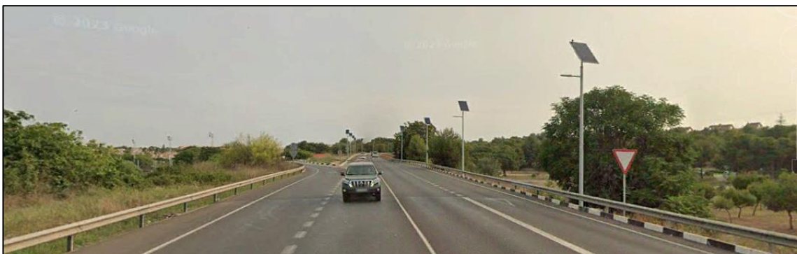
Figura 93. Fotografía de la sección transversal de la carretera en el PK 3+550.
