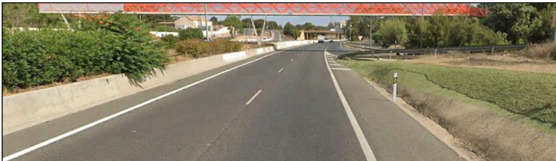
Figura 85. Fotografía de la sección transversal de la carretera en el PK 1+740
