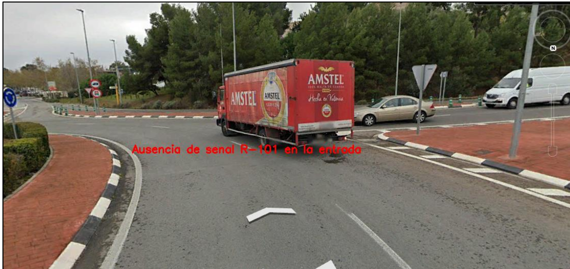
Figura 167. Ausencia de señal R-101 en el carril de entrada O
