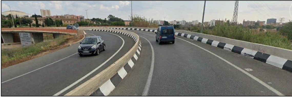
Figura 80. Fotografía de la sección transversal de la carretera en el PK 0+200
