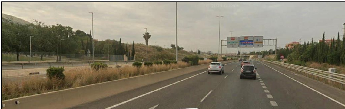
Figura 84. Fotografía de la sección transversal de la carretera en el PK 1+280
