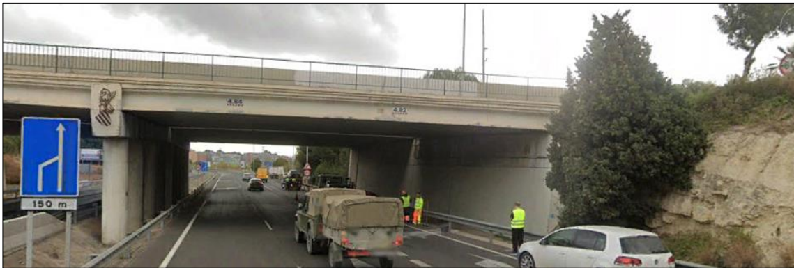
Figura 90. Fotografía de la sección transversal de la carretera en el PK 2+850, sentido ascendente
