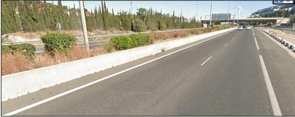
Figura 83. Fotografía de la sección transversal de la carretera en el PK 1+020
