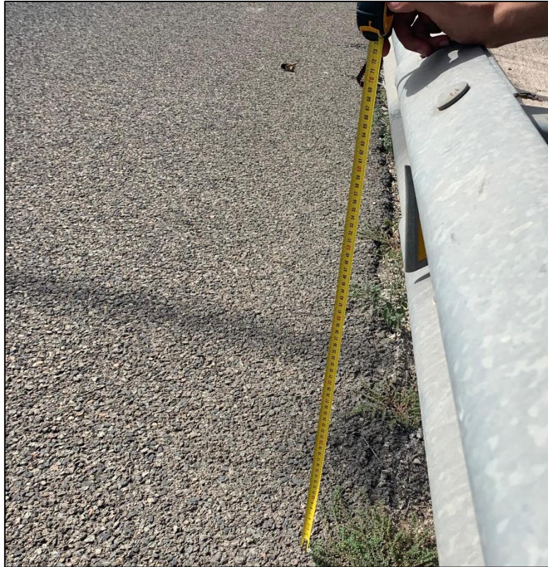
Figura 134. Altura suficiente de la barrera metálica en el PK 3+200 en sentido ascendente (75cm)
