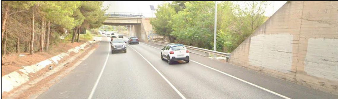
Figura 92. Fotografía de la sección transversal de la carretera en el PK 3+400.
