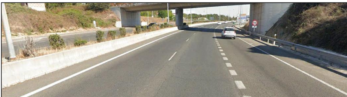
Figura 82. Fotografía de la sección transversal de la carretera en el PK 0+780
