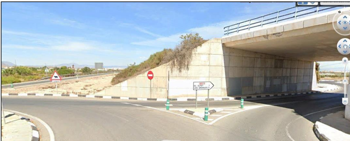
Figura 11. señal R-101 en el carril de entrada a la rotonda
