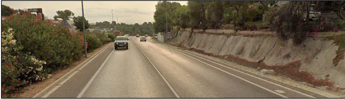
Figura 94. Fotografía de la sección transversal de la carretera en el PK 4+100.
