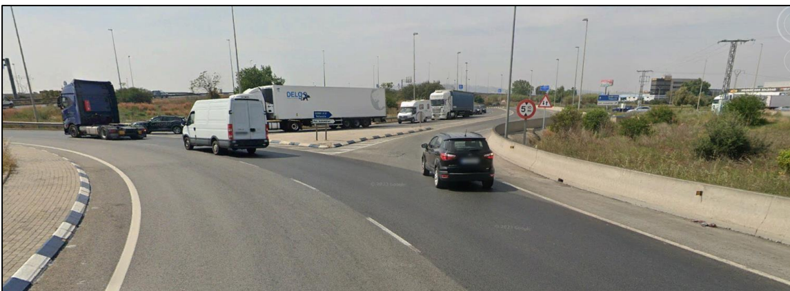
Figura 53. Flujo de tráfico saliente de una glorieta.
