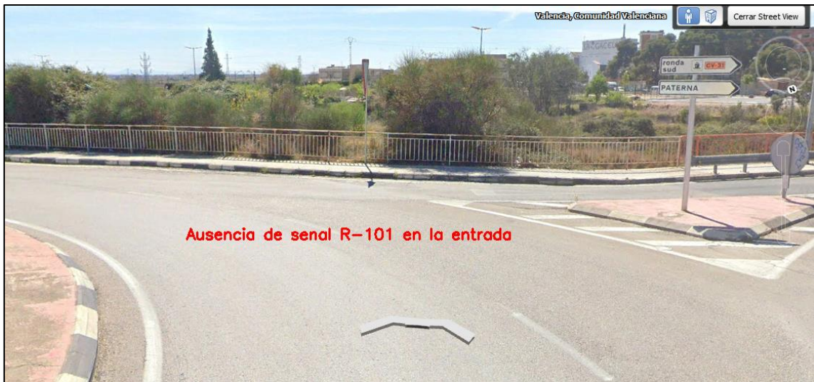
Figura 147. Ausencia de señal R-101 en el carril de entrada O
