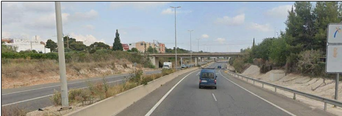
Figura 81. Fotografía de la sección transversal de la carretera en el PK 0+500
