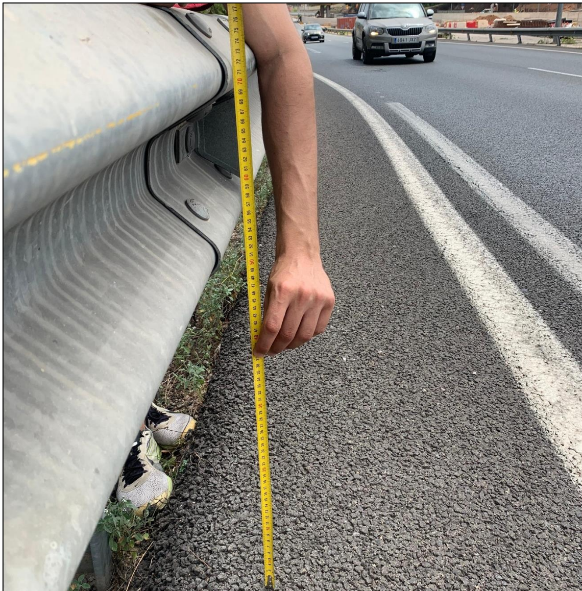
Figura 126. Altura suficiente de la barrera metálica en el PK 2+275 en sentido ascendente (76cm)
