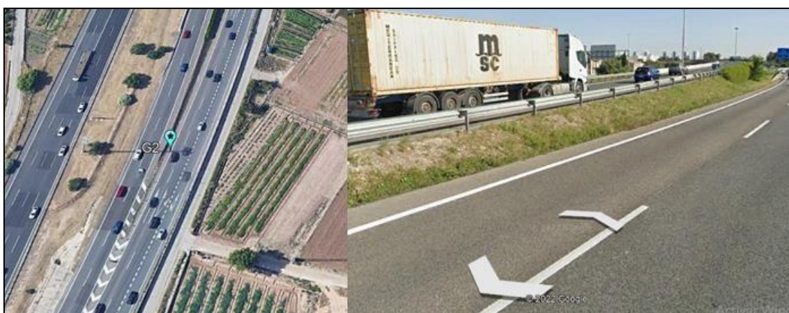
Figura 2. Barrera metálica cuya cara dorsal da a la carretera, en una divergencia de vías.
