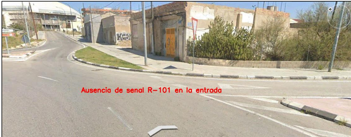
Figura 149. Ausencia de señal R-101 en el carril de entrada SE
