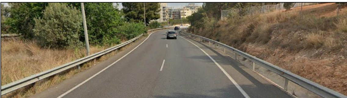
Figura 88. Fotografía de la sección transversal de la carretera en el PK 2+450, sentido ascendente
