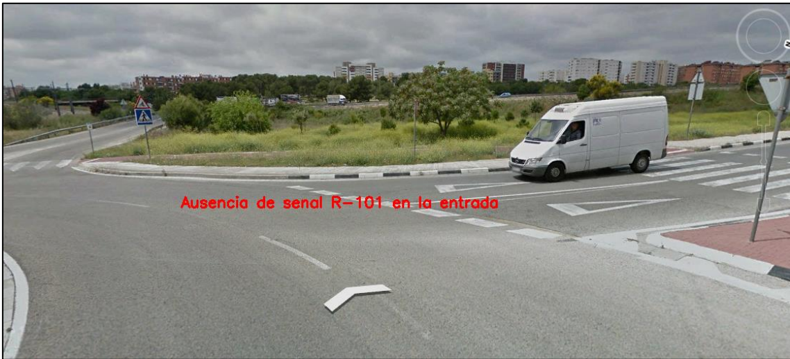
Figura 165. Ausencia de señal R-101 en el carril de entrada NO
