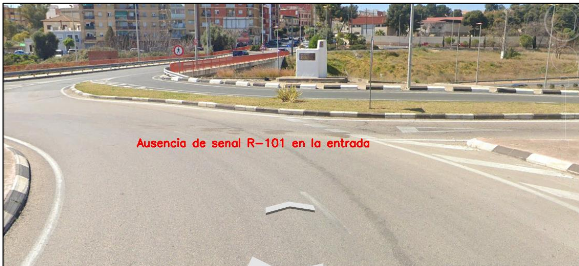
Figura 146. Ausencia de señal R-101 en el carril de entrada NNO
