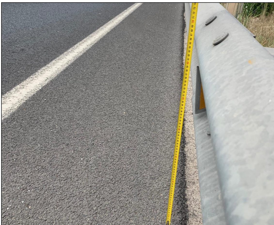
Figura 121. Altura suficiente de la barrera metálica en el PK 1+750 en sentido ascendente (75cm)
