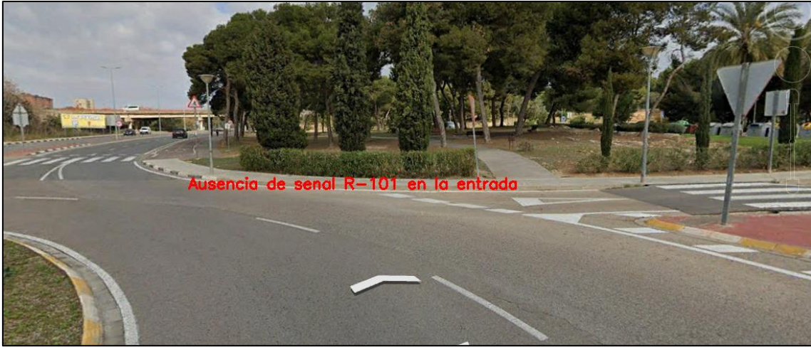
Figura 164. Ausencia de señal R-101 en el carril de entrada NE
