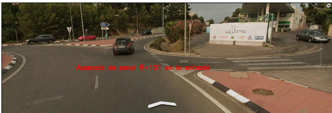
Figura 171. Ausencia de señal R-101 en el carril de entrada NO
