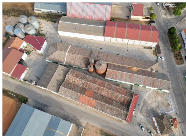
Ilustración 62 - Vista aérea (Fuente: propia)
