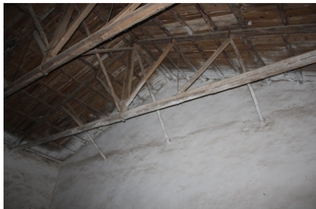
Ilustración 64 - Almacén 2 (Fuente: propia)
