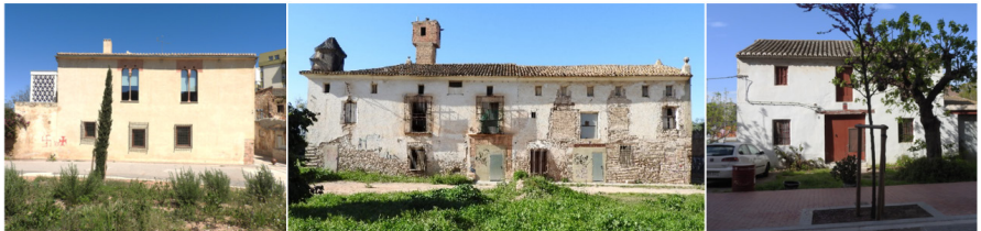
Figure 1. The three main historical types of alquerías: late medieval alquería (alq. del Moro), silk alquería (alq. de Falcó), casa de labrador (alq. Visquet). Source: (Gosselin 2022)
