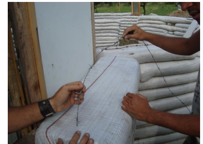
Bandeo, J. 27/02/2013 Como construir en Superadobe paso a paso.
