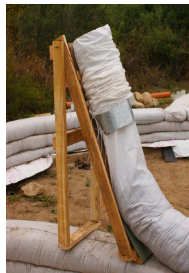
Bandeo, J. 27/02/2013 Como construir en Superadobe paso a paso.
