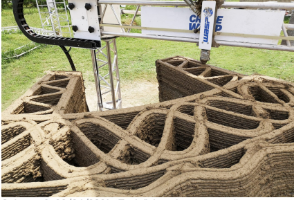
Solarat, C. 28/04/2021, "Tecla", la primera casa impresa con arcilla en 3D, diseñada por el arquitecto Mario Cucinella
