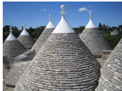
May John, 2010 "CASAS HECHAS A MANO Y OTROS EDIFICIOS RADICIALES ARQUITECTURA POPULAR", Pág 70-71
