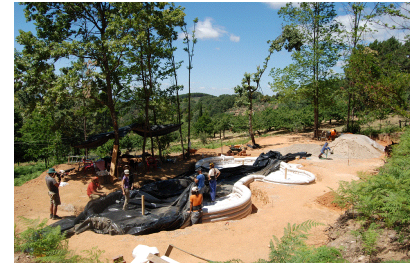
Redacción. 18/07/2015 Taller de bioconstrucción con técnica de "Superadobe" en Guisando
