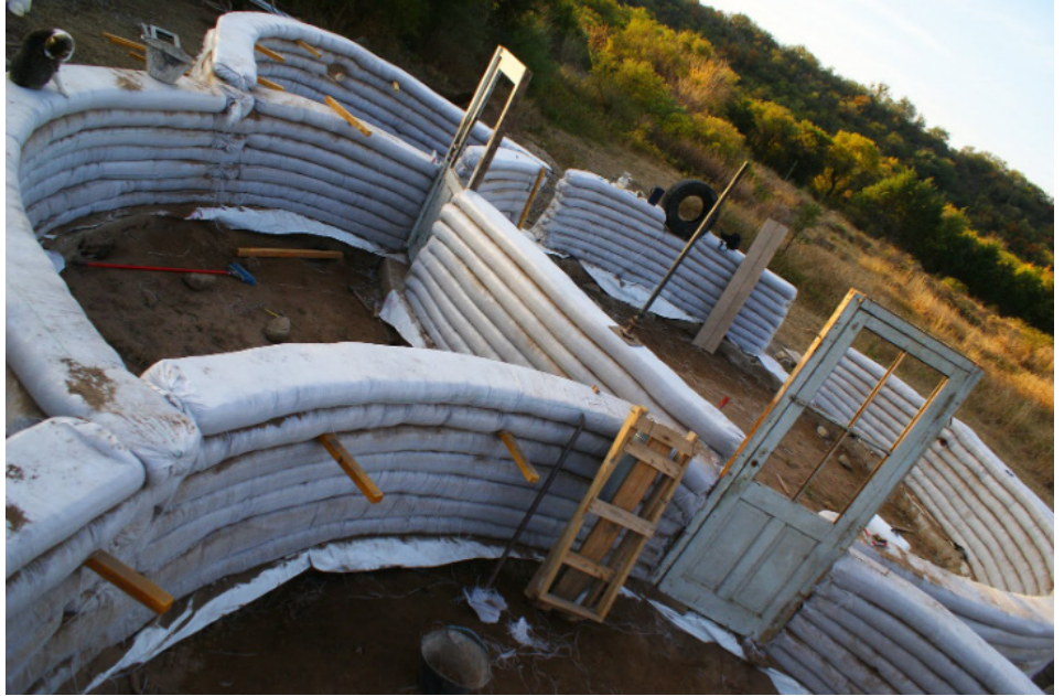
Bandeo, J. 27/02/2013 Como construir en Superadobe paso a paso.
