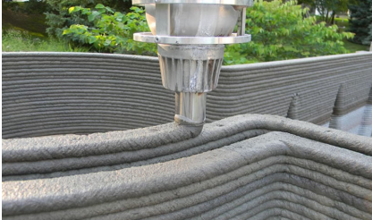
Nueva vivienda construida con una impresora 3D 08/06/2020
