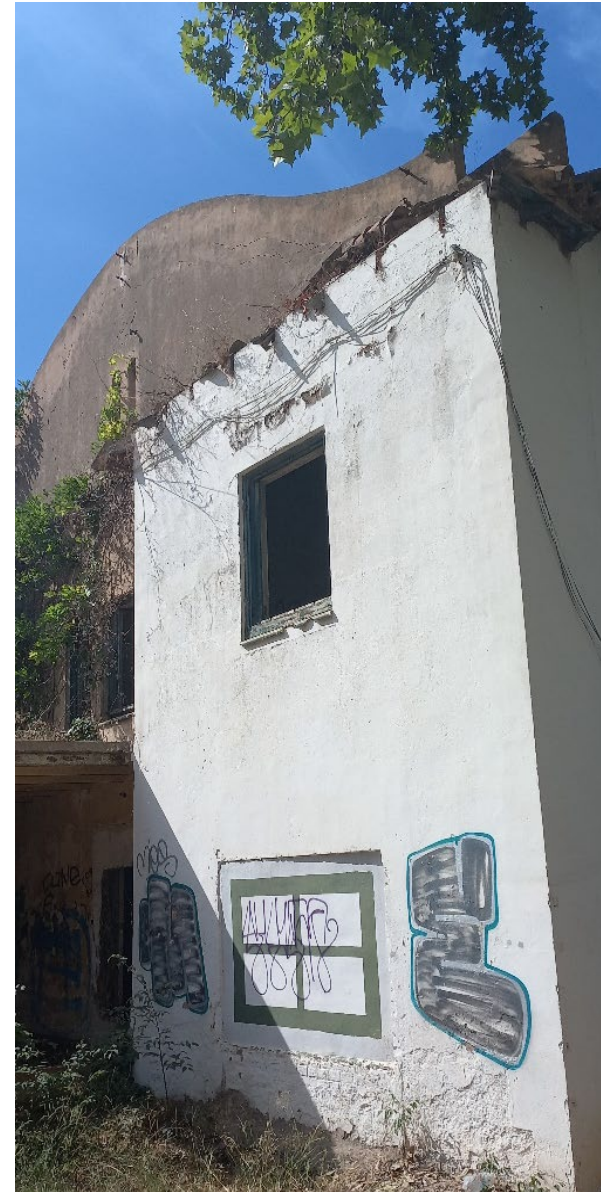
Figura 46. Cerramiento de vanos en planta baja. Autora: H. Quintanilla (julio 2023).
