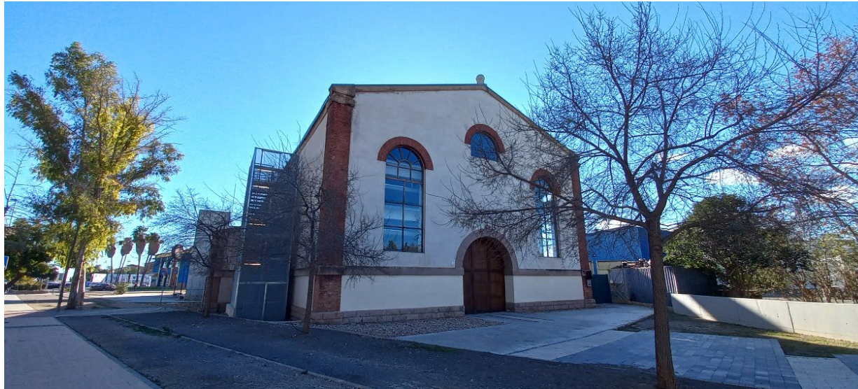
Figura26. Nave de Almacén de Efectos y Repuestos. Autora: H. Quintanilla (enero 2022).
