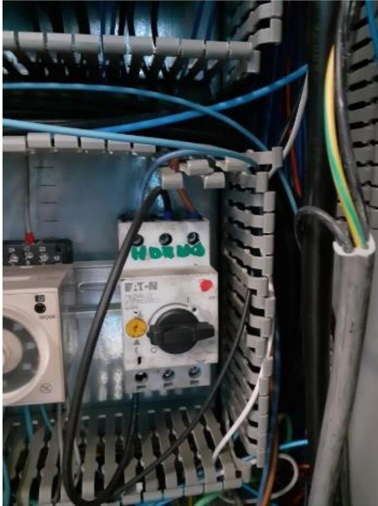
Figura IV.80 Interruptor térmico de corriente de la resistencia del sistema horno túnel.
