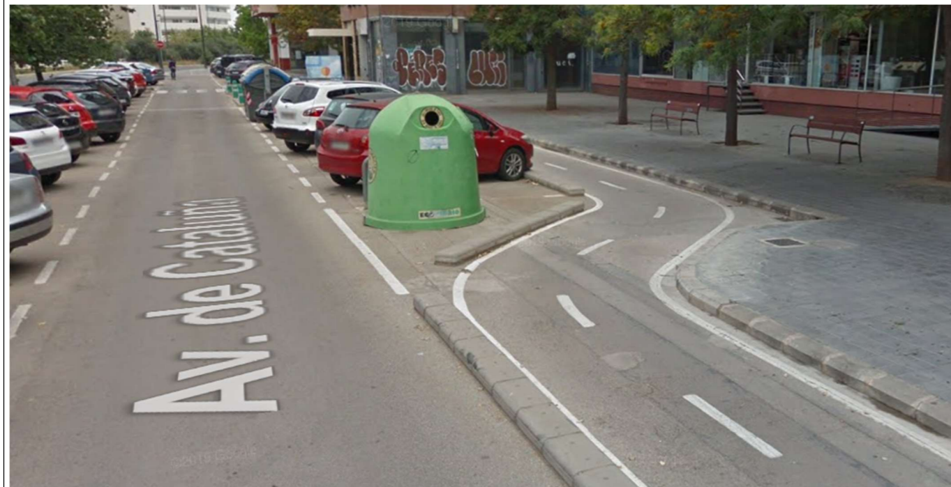
Imagen 13. Radios de giro insuficientes para una velocidad de deseable de 20km/h. Trazado sinuoso entre calle Palancia y Santa Cruz de la Zarza. Fuente: Google Maps.
