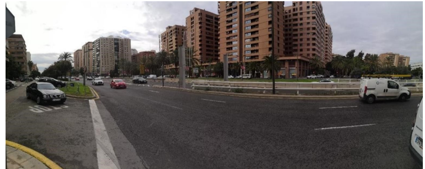
Imagen 9. Avenida Catalunya. Vía de servicio y emboquille paso inferior.
