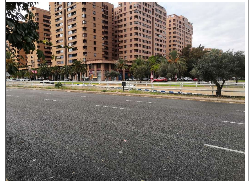
IMAGEN 57; Vista del paso inferior V-21 y viales laterales de acceso a glorieta de Torre Miramar desde zona de estudio.
