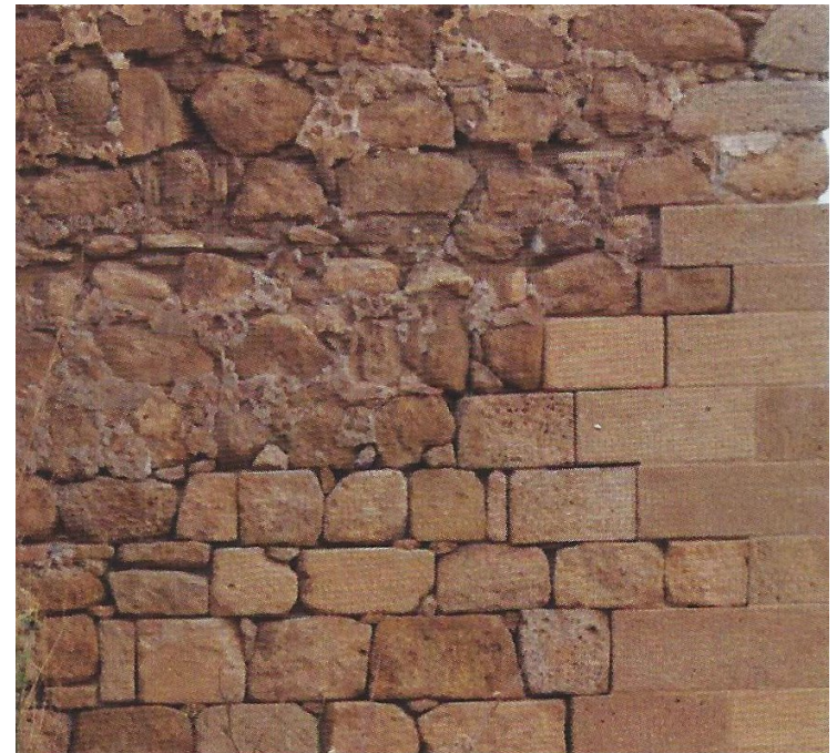
Figura 31: Ejemplo de recomposición de muro de sillería, donde se distingue las piezas recolocadas pero sin destacarse excesivamente de la obra original. (Vegas y Mileto, 2017).
