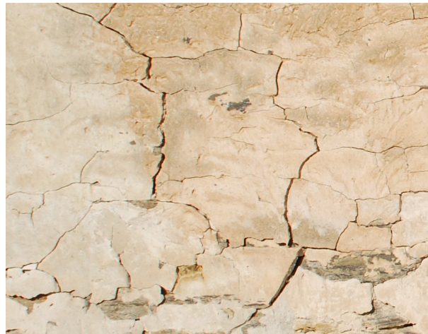
Figura 37: una de las zonas del enlucido de la fachada oeste donde aplicar esta intervención (Elaboración propia).
