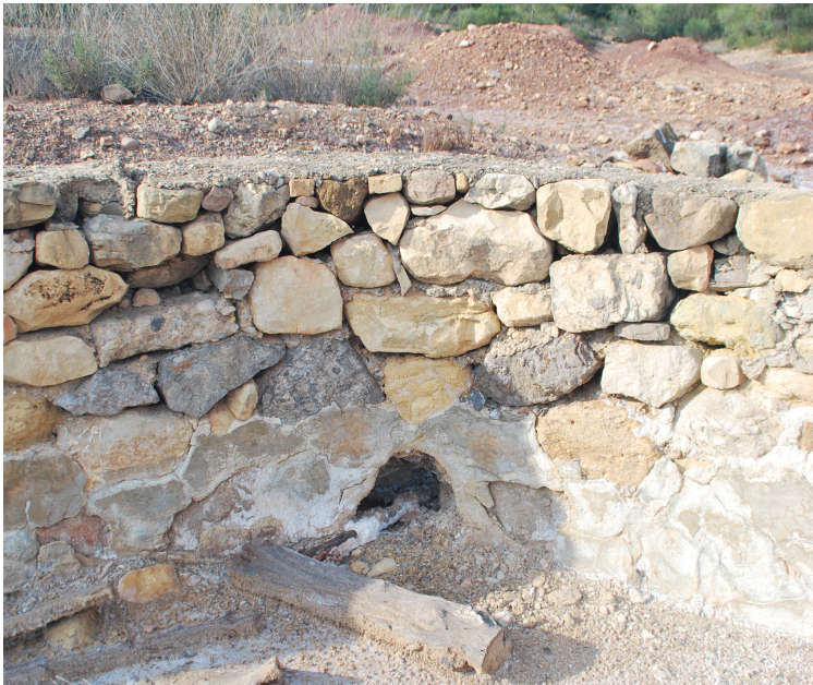
Figura 28: Detalle de la apertura por donde se llenaba la pileta desde el pozo directamente (Elaboración propia).
