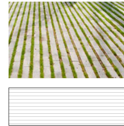
7 Pavimento permeable de hormigón
