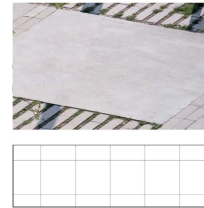
5 Pavimento de baldosa de hormigón 90x90 cm
