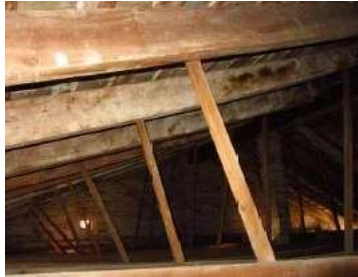
Figura 52. Subestructura con tirantes para falso techo. Fuente propia
