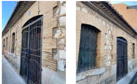
Figura 47. Puerta y ventanas de la fachada principal. Fuente propia
