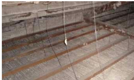
Figura 53. Falso techo de cañizo.2013. Riunet.upv.com
