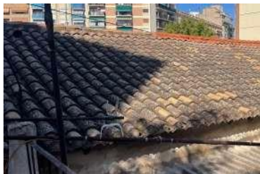
Figura 49. Cubierta vista patio interior. Fuente propia
