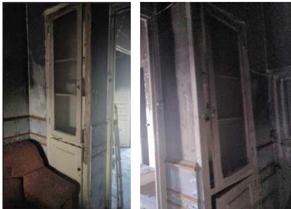
Figura 42. Pilar de ladrillo macizo existente en la vivienda junto a armarios empotrados. Fuente propia
