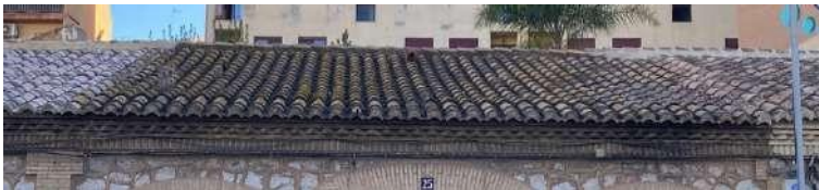
Figura 48. Cubierta a dos aguas hacia fachada con acabado en teja curva. Fuente propia
