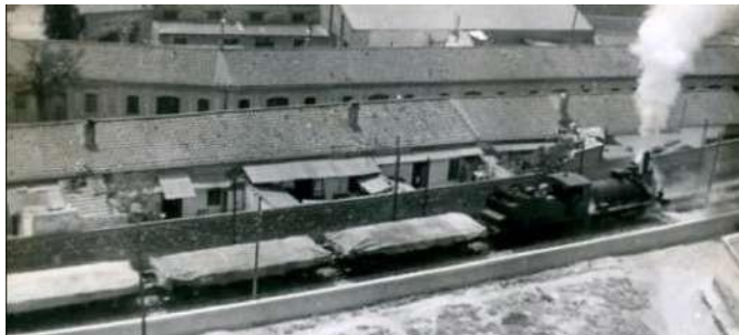
Figura 13. Vía Férrea desde calle Tres Forques. Remember-Valencia, pg 1077.
