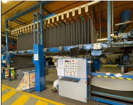
Imagen nº 17: Acumulador de espuma para evitar paradas de máquina por cambio de rollos de espuma.
