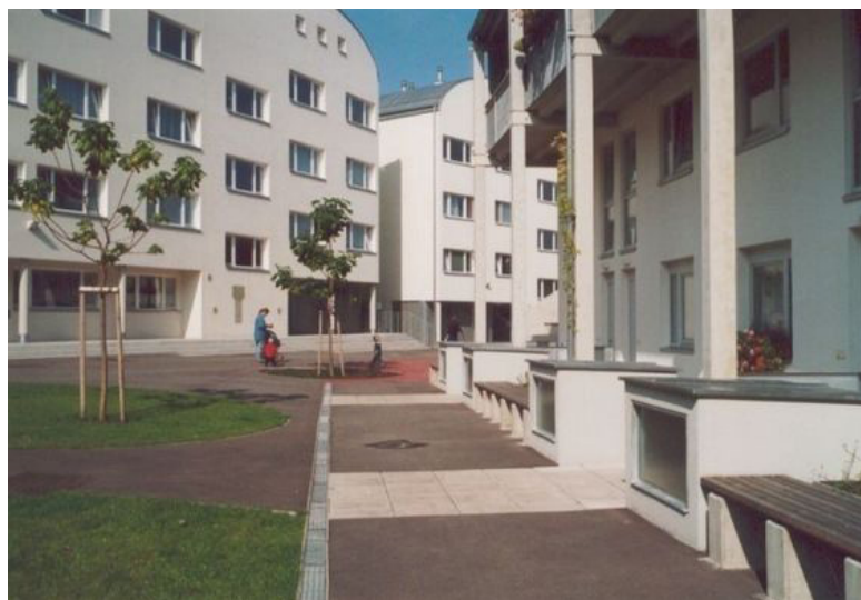
Figura 42. Vista exterior del conjunto proyectado por Franziska Ullman en el Margarete Schütte-Lihotzky Hof
