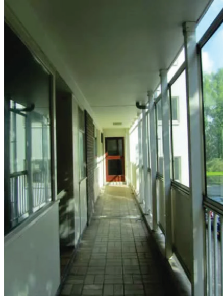
Figura 41. Corredor de acceso a las viviendas del RVS Flat
