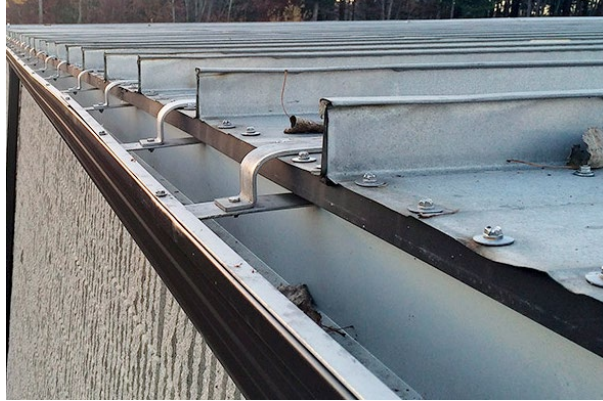
Figura 28.- Evacuación de aguas
