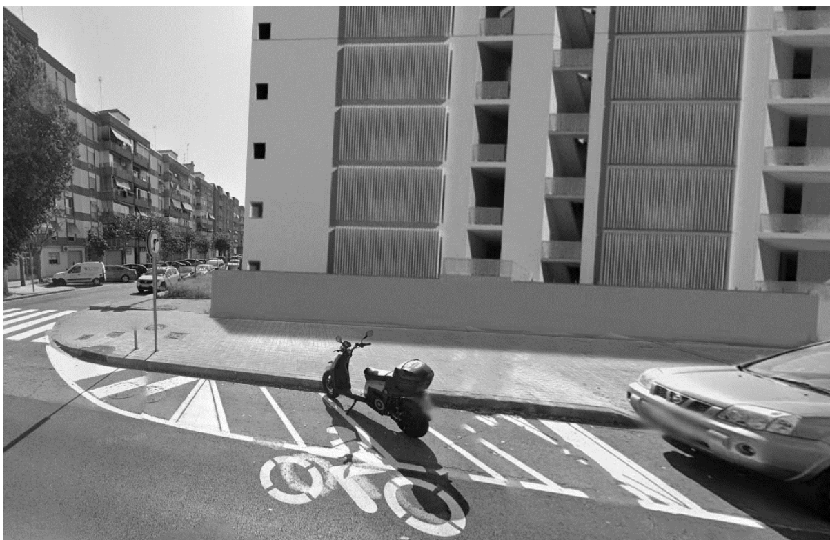
Ilustración 10. Emplazamiento del edificio 3D con vista desde calle Ingeniero Fausto Elio, 50, Valencia
