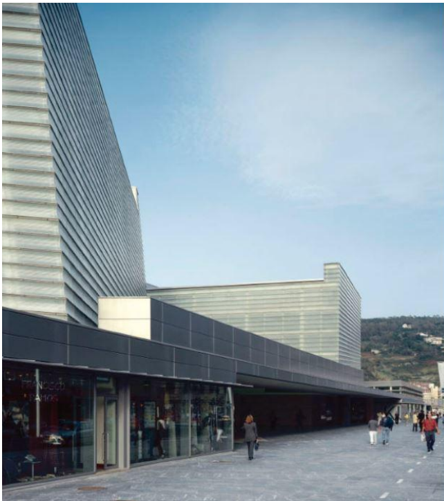
Ilustración 83. Vista del acceso desde el Urumea. Duccio Malagamba. Fuente: Duccio Malagamba.
