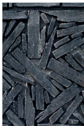
Ilustración 7. Recubrimiento vertical de la plataforma. Roland Halbe. Fuente: Roland Halbe.
