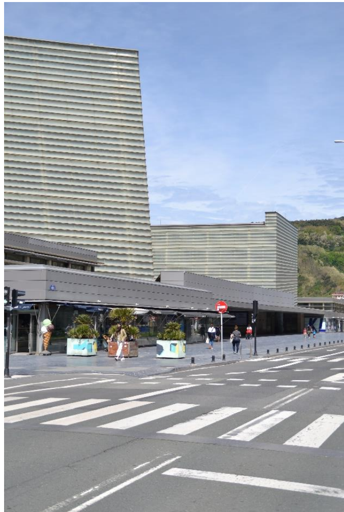
Ilustración 136. Vista del acceso desde el río Urumea. Elaboración propia.
