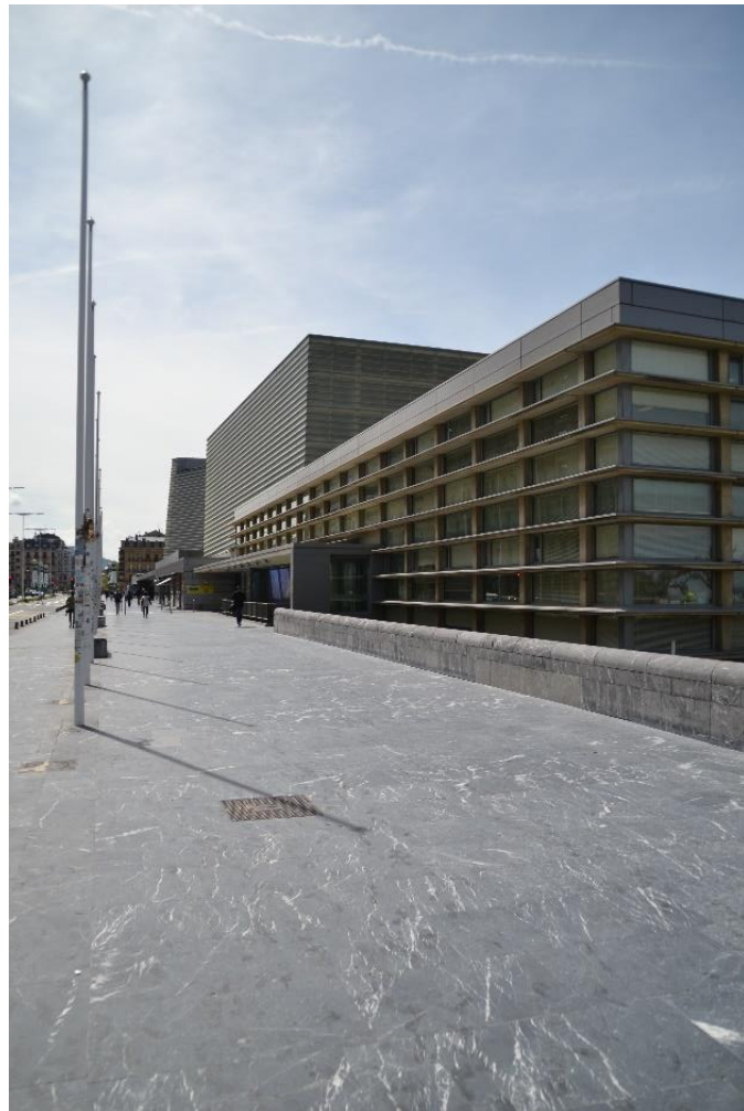
Ilustración 138. Vista del acceso desde la derecha. Elaboración propia.
