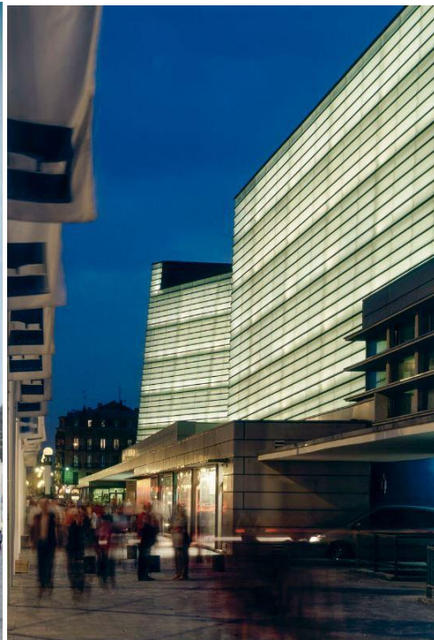
Ilustración 84. Vista del acceso desde la izquierda. Duccio Malagamba. Fuente: Duccio Malagamba.
