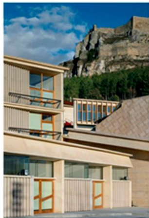
Ilustración 14. Enric Miralles / Carme Pinós. Escuela-hogar. Morella, Castellón. Fuente: Duccio Malagamba
