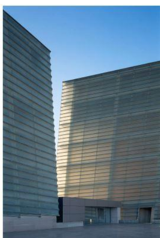
Ilustración 6. Unión de los dos cuerpos desde la terraza posterior. Duccio Malagamba. Fuente: Duccio Malagamba.
