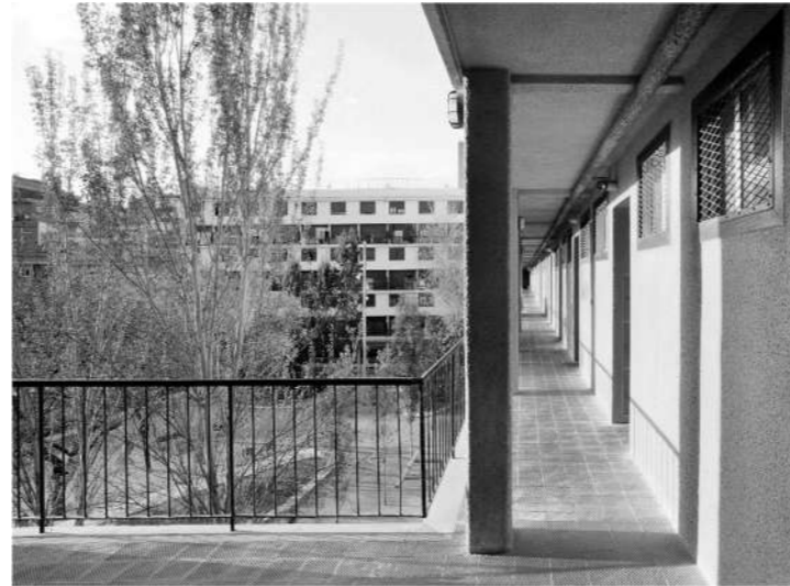
Fig. 8_ Casa Bloc. Accesos en altura
