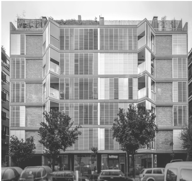
Figura 27. Fotografía de la fachada sureste con su protección solar. Fuente: www.docomomoiberico.com
