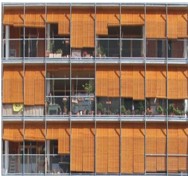
Figura 18. Fotografía de la fachada sur del edificio La Borda Fuente: www.laborda.coop
