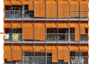
Figura 4: Fotografía de la fachada sur del edificio la Borda Fuente: www.laborda.coop
