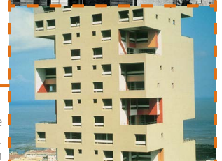
Figura 7: Fotografía de un tramo de la torre Kanchanjunga con sus terrazas. Fuente: www.wordpress.com
