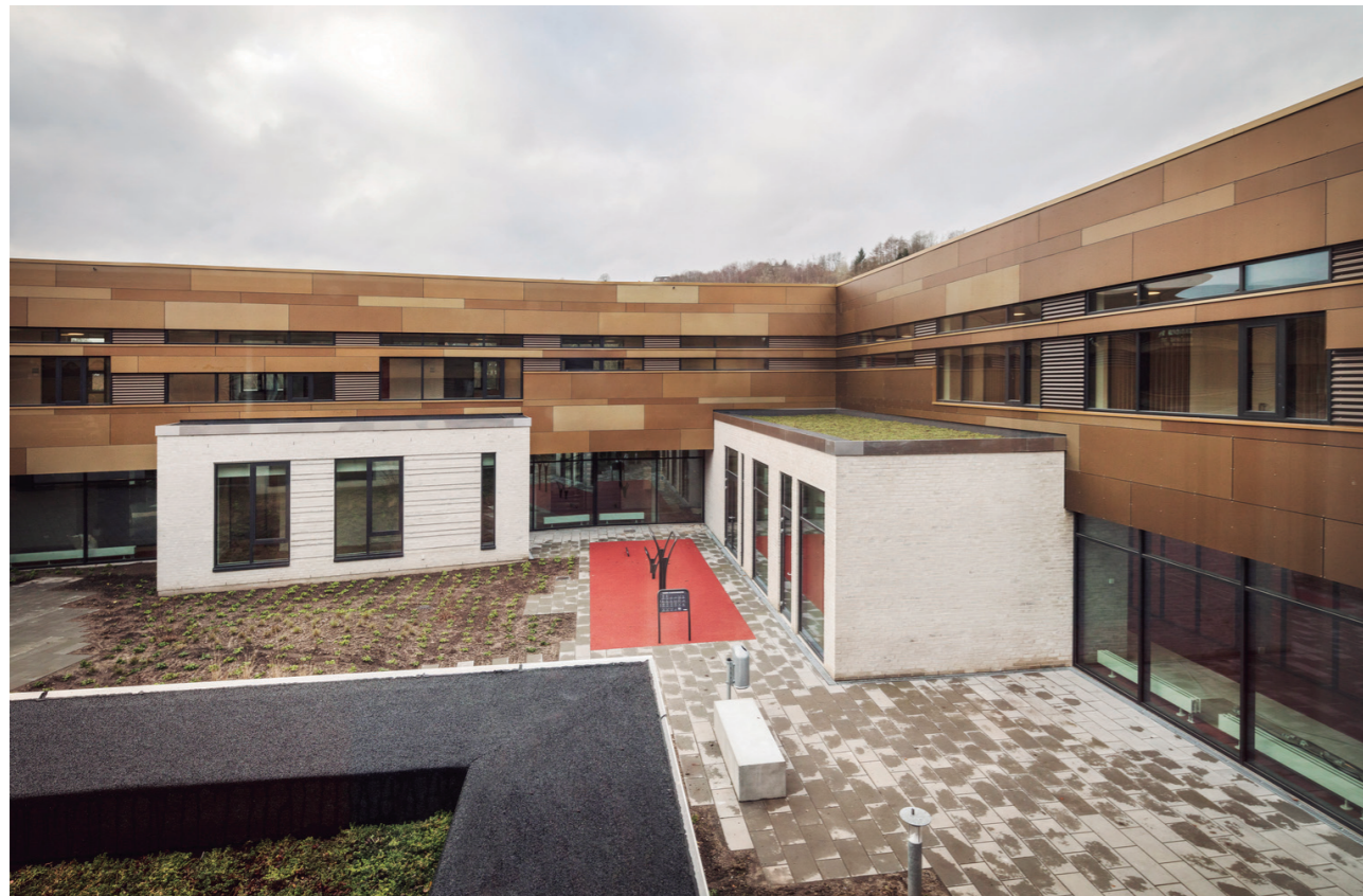
Fig. 44 Cubiertas verdes del Hospital Psiquiátrico Vejle.
