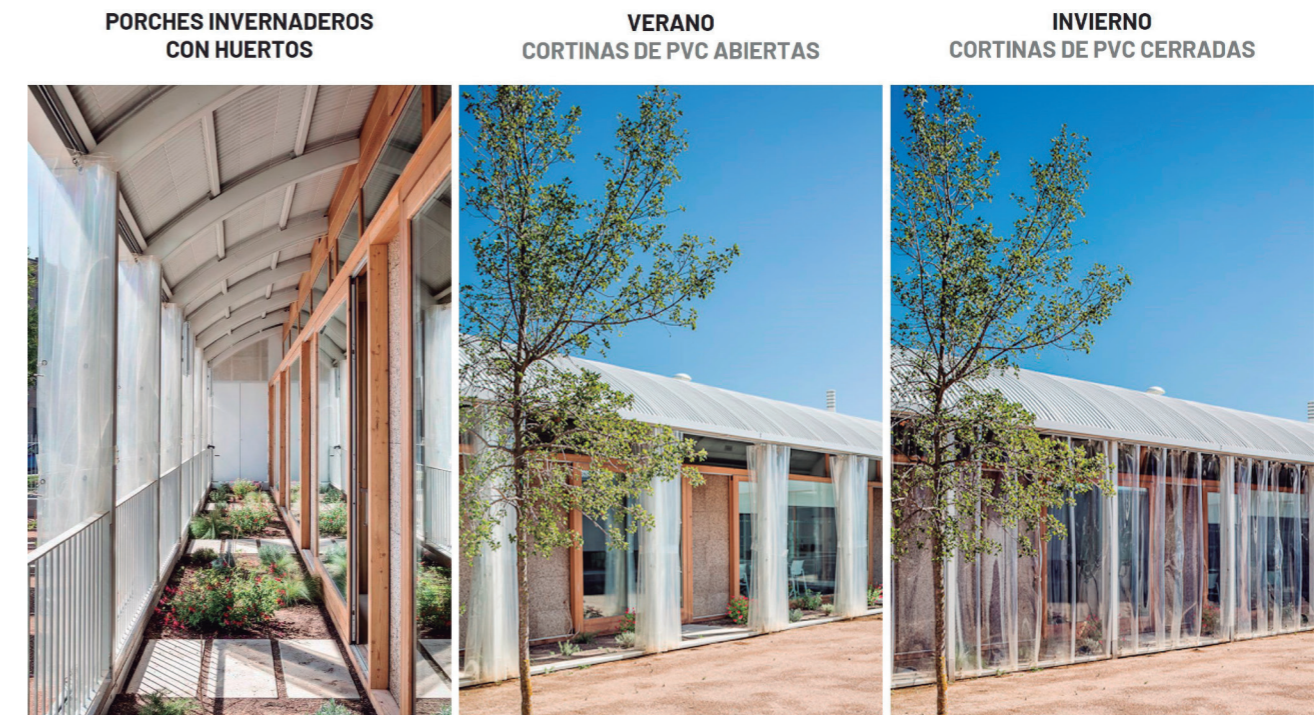
Fig. 52 Sistema de cerramiento en la fachada sur del Centro Psicopedagógico de Osona. del centro asistencial deviene de mantener una equidad entre pacientes y equipo médico, favoreciendo su interacción, e, igualmente, propiciar los desplazamientos de este tipo mobiliario desde un pabellón a otro cuando las actividades así lo requieran.
