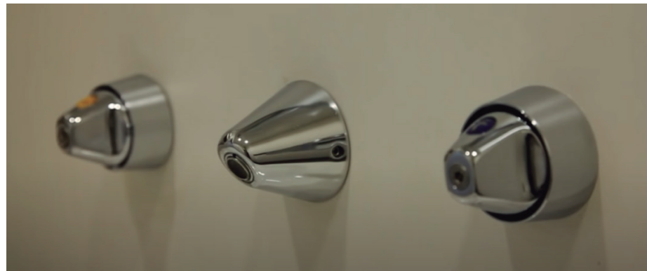
Fig. 92 Manillas de grifo antiataduras en el cuarto de baño.
