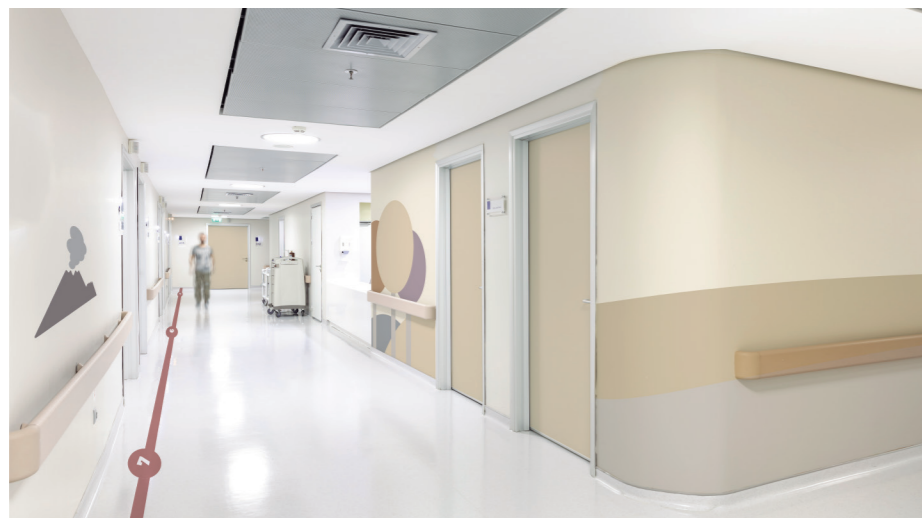
Fig. 19 Pasillo hospitalario con identificación gráfica, iluminación apropiada y esquinas redondeadas.
