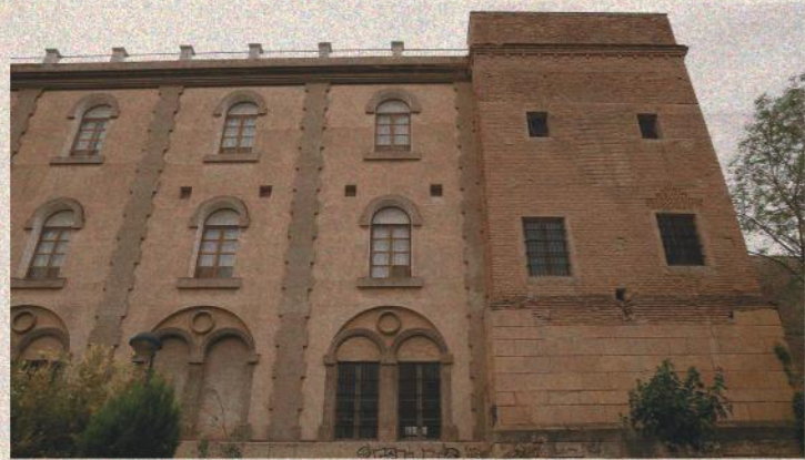
Img. 38 Vista de la fachada sur en la actualidad.
