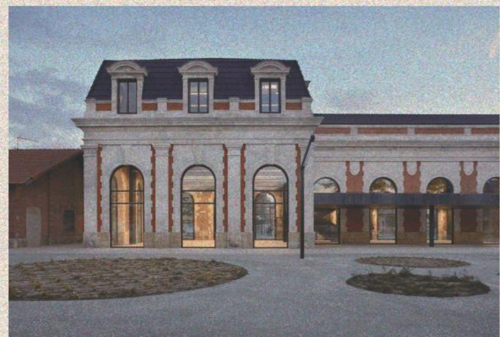
Img. 46 Vista del exterior de la estación de Burgos.
