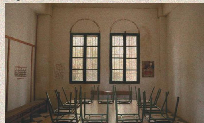
Img. 35 Interior de una de las aulas de Planta Baja.
