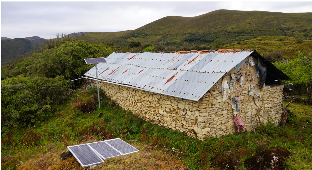
Figura 14. Instal·lació solar al refugi de Diego López
