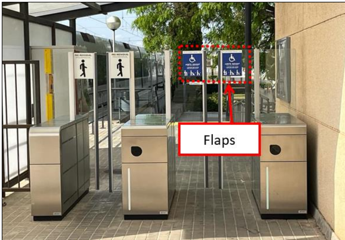
Figura 70. Acceso principal al andén principal (Fuente: Elaboración propia)
