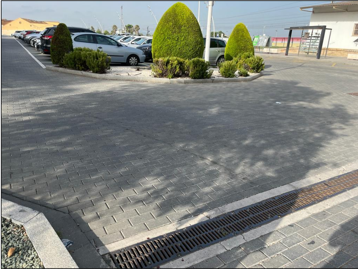
Figura 39. Sumideros en el pavimento ubicado en el aparcamiento de vehículos privados (Fuente: Elaboración propia)
