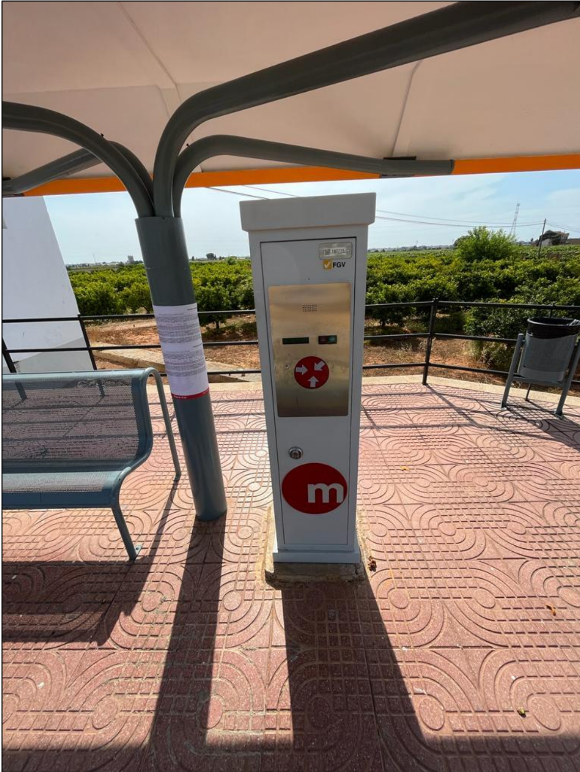
Figura 138. Infraestructura para la validación del ticket (Fuente: Elaboración propia)
