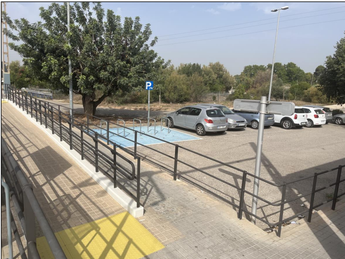
Figura 100. Acceso en bicicleta al edificio principal (Fuente: Elaboración propia)
