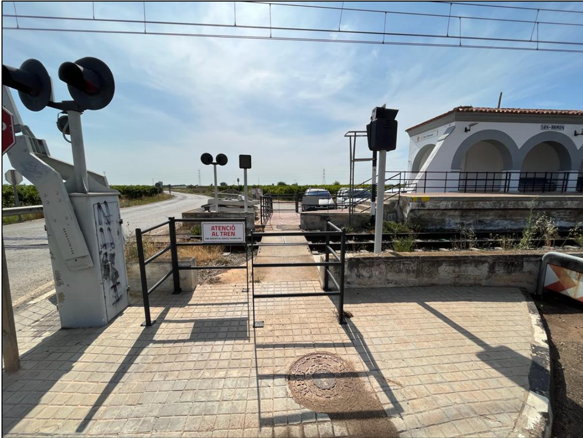
Figura 132. Tipo de vallado, a pies de las vías férreas (Fuente: Elaboración propia)
