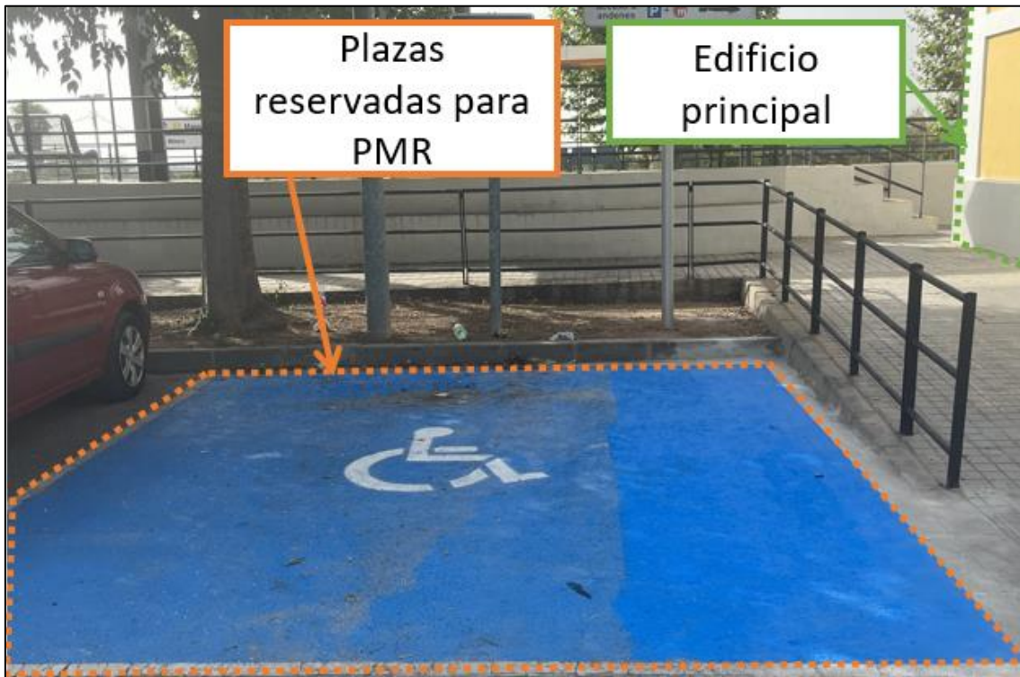
Figura 102. Plazas reservadas para estacionamiento de vehículos de PMR en el intercambiador (Fuente: Elaboración propia)
