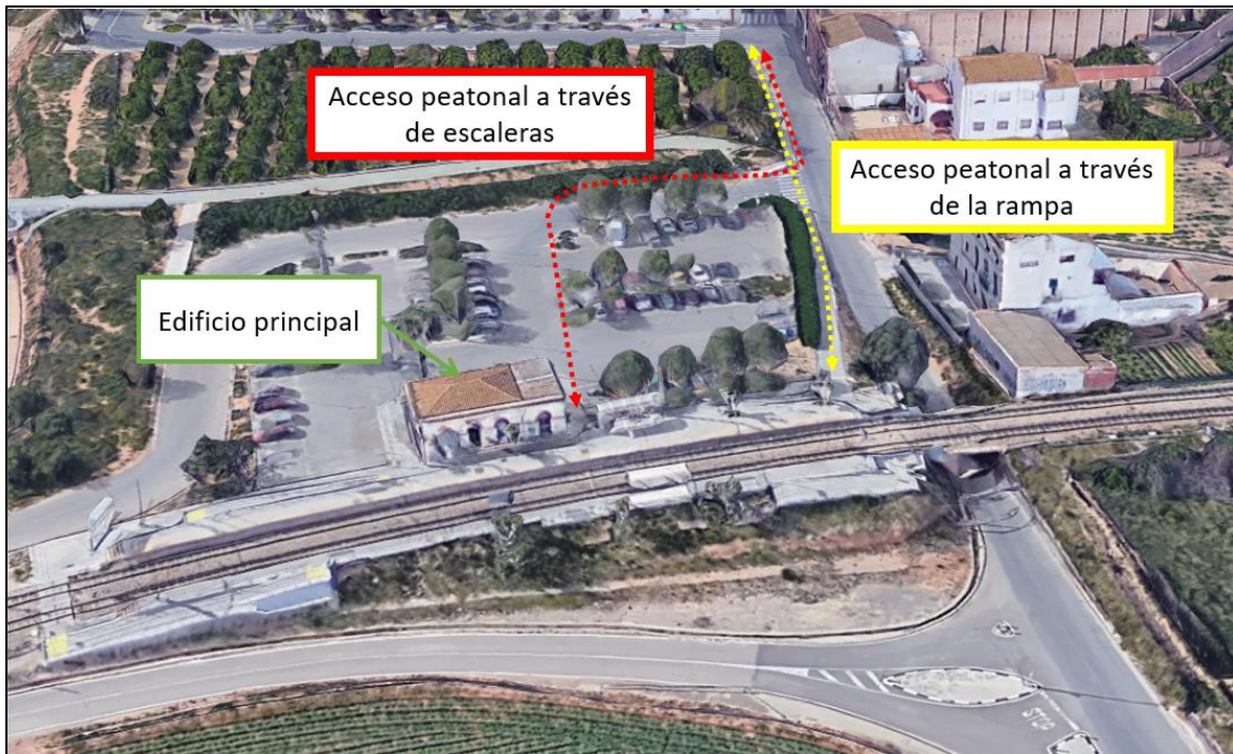
Figura 96. Rutas de acceso a pie al edificio principal desde el camino Fondo de Borbotó (Fuente: Elaboración propia)
