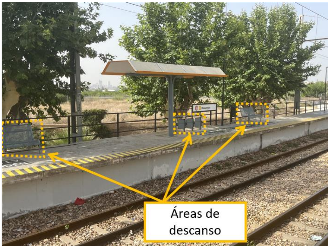
Figura 111. Área de descanso, varios bancos y sillas plegables (Fuente: Elaboración propia)
