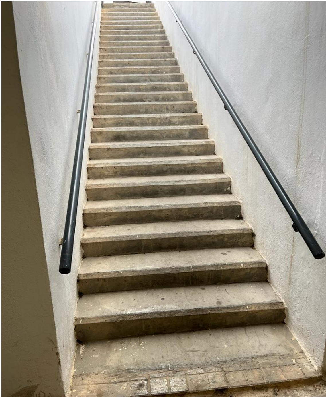
Figura 77. Escaleras, las cuales acceden al andén en servicio (Fuente: Elaboración propia)
