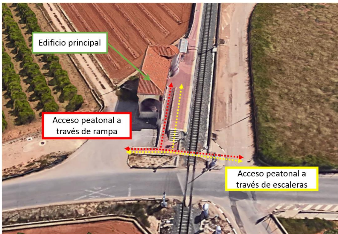
Figura 128. Rutas de acceso a pie al andén principal desde el aparcamiento de vehículos privados (Fuente: Elaboración propia)
