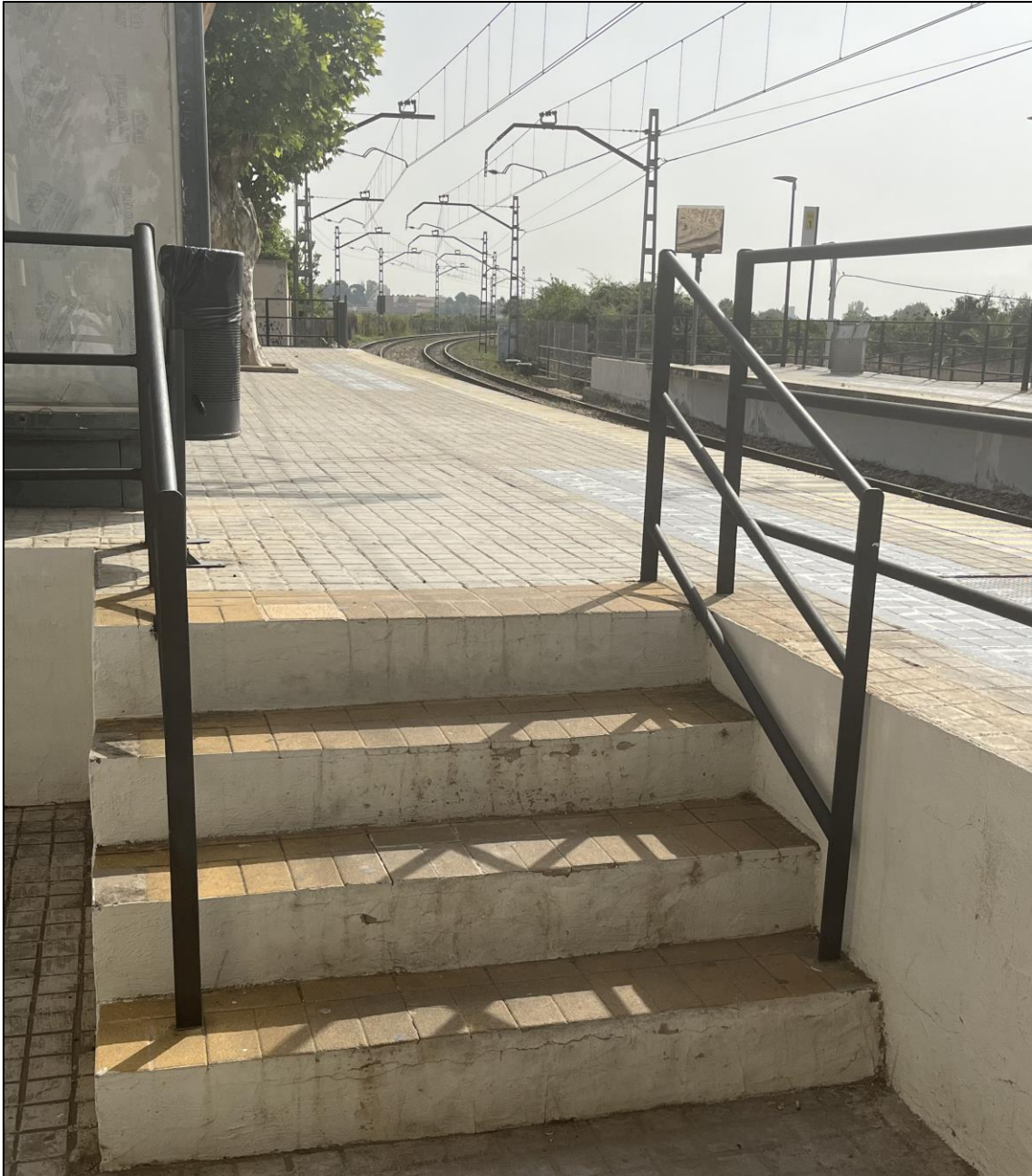
Figura 108. Acceso al andén principal a través de escaleras (Fuente: Elaboración propia)
