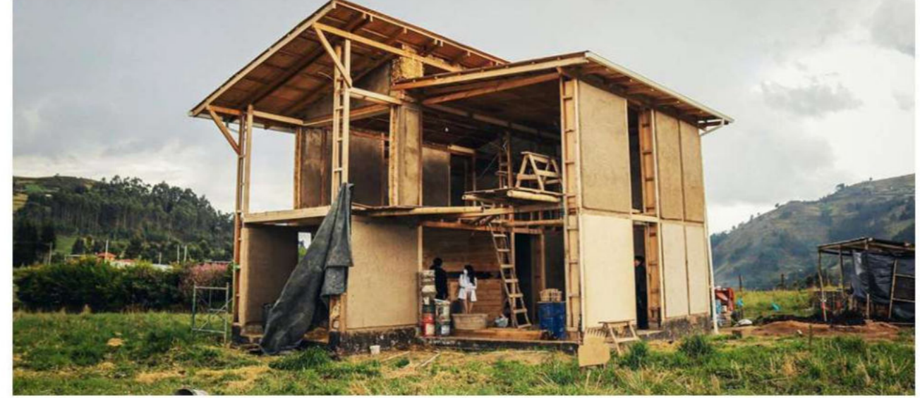
figura 45. Casa Natura y Arte/fotografía de la construcción.
