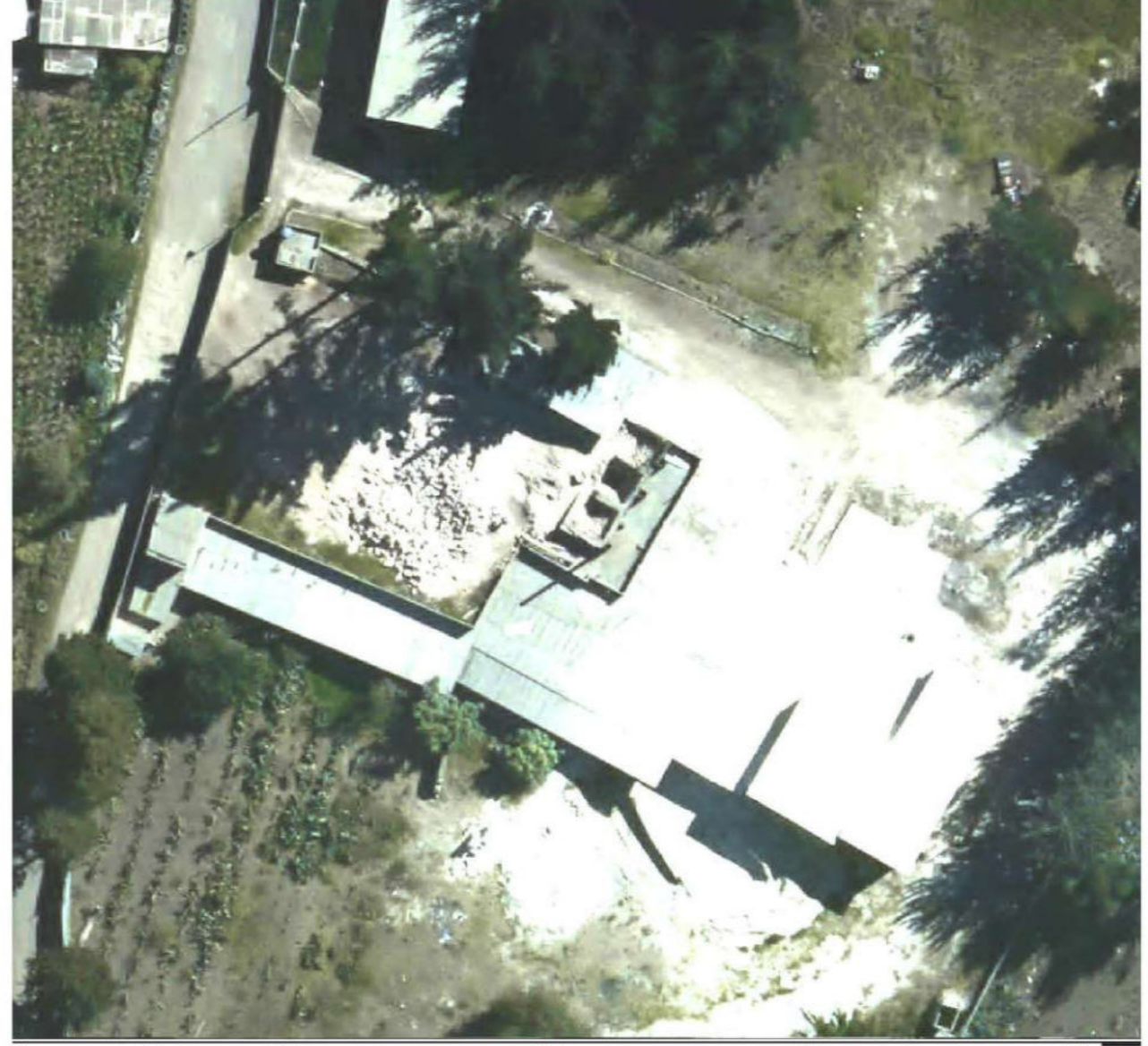
figura 54: Fabrica de cal "Calera Ferticamicrus".
