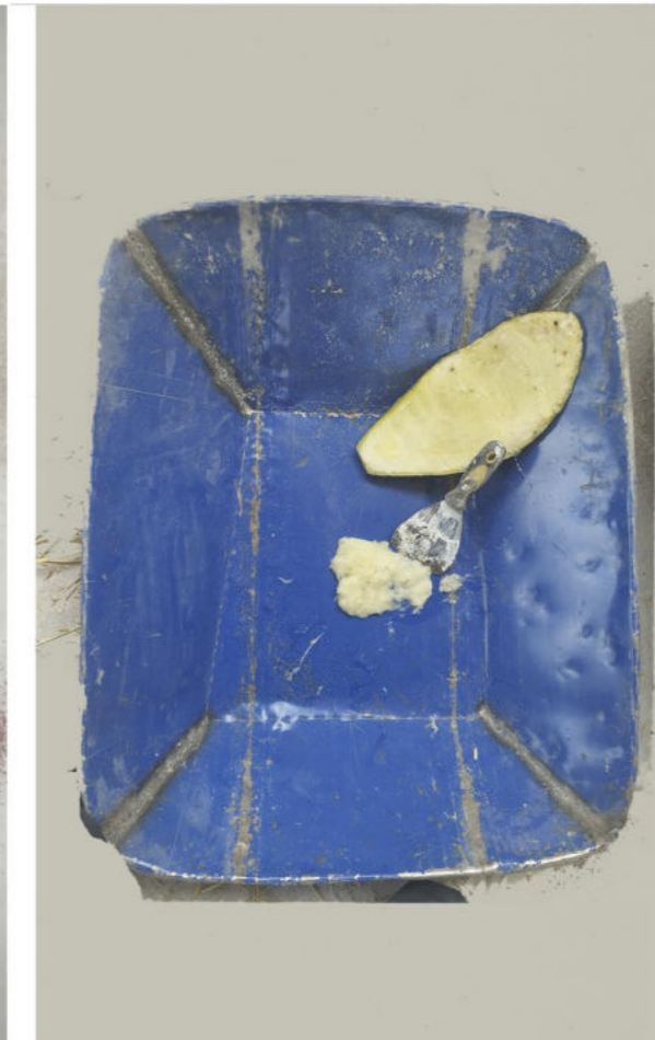
figura 69: se utiliza una pastera, para mezclar la goma de tuna (4 hojas de tuna)
