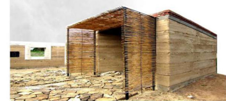
figura 29. Muros de construcción tradicional de tapial.
