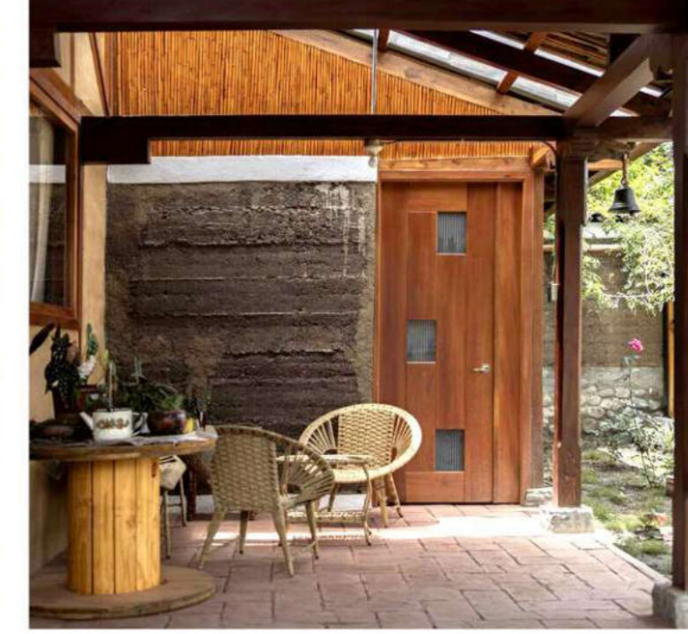
figura 26. Muro de tapial, Casa Condor.
