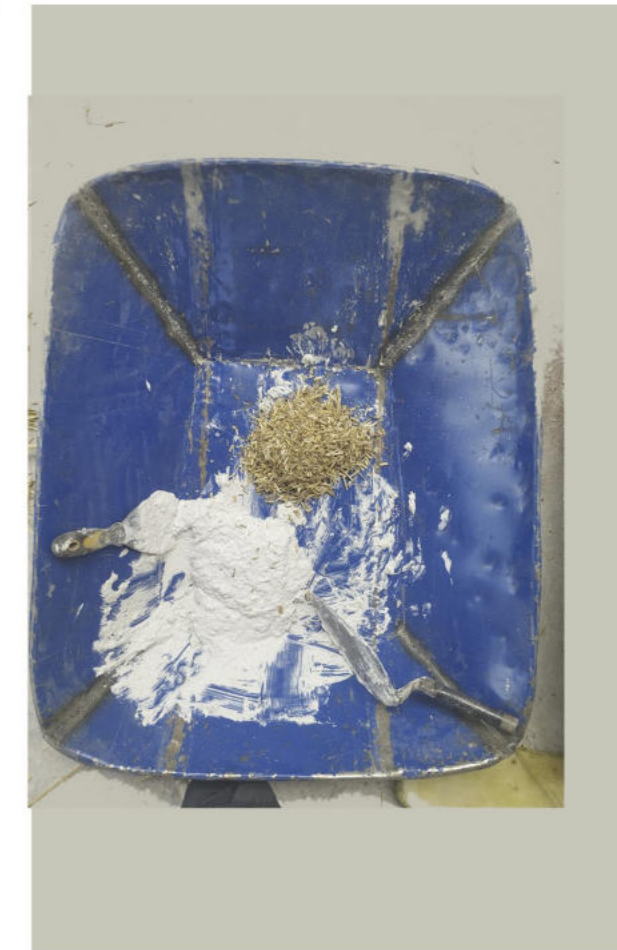
figura 70: Se coloca el mortero de cal y se mezcla al mismo tiempo con la paja de cebada previamente trituradas a un 1 cm de largo.
