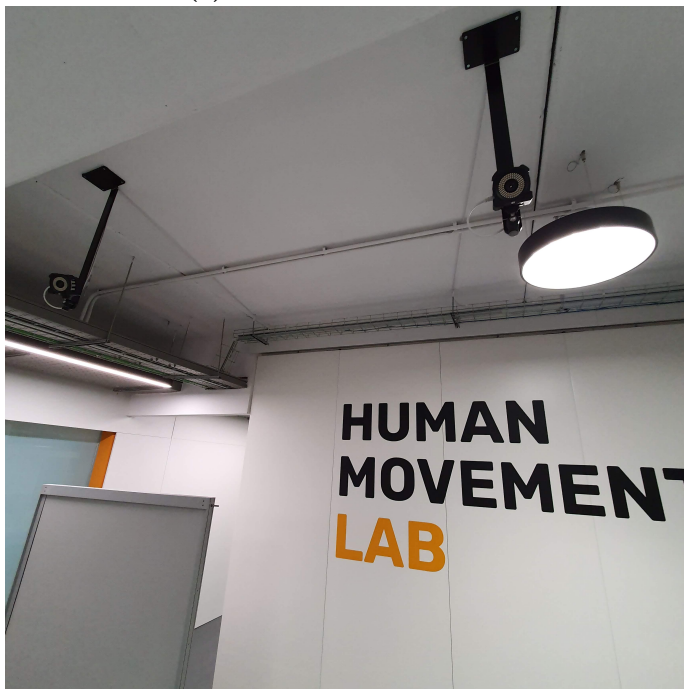
(b) Instalación de las cámaras de fotogrametría
