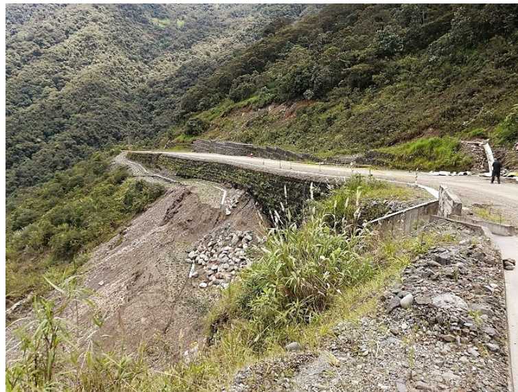
Figura 4-2 Vista de la parte media del área del deslizamiento investigado donde la carretera fue afectada (cortada) y reconstruida empleando muros de contención de tierra armada. En esta zona, el deslizamiento se encuentra aún propenso a continuar con una tasa de desplazamiento baja, según los técnicos de CELEC-EP. Se puede observar también la fuerte pendiente que domina todo el entorno.
