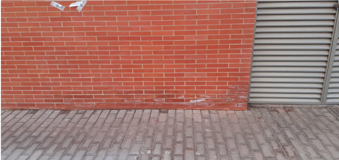
Ilustración 74: Fotografías del edificio 6C.
