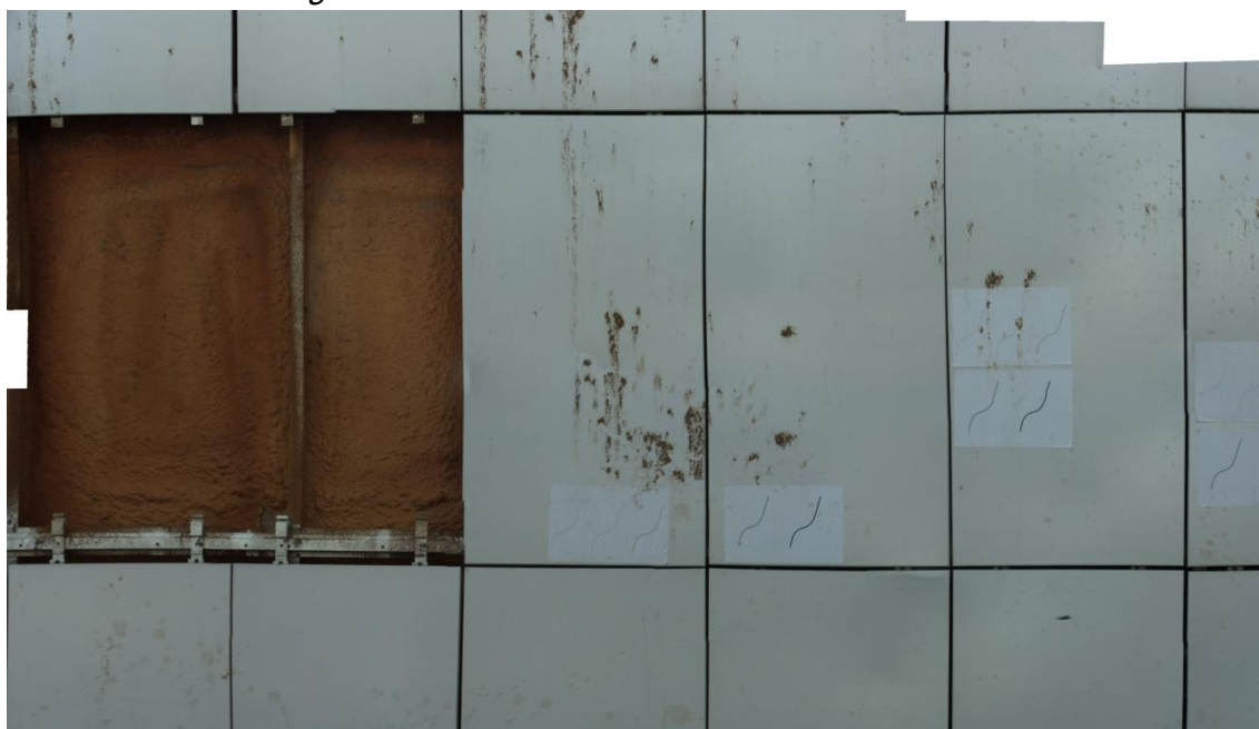
Ilustración 137: Imagen reconstruida por el sistema ROBIM.
