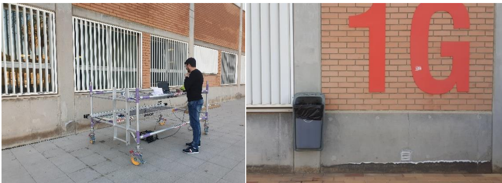
Ilustración 69: Fotografía del edificio 1G.
