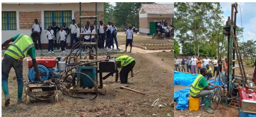
Figura 02: Misión de Kafakumba trabajos de instalación y funcionamiento de pozo de agua potable
