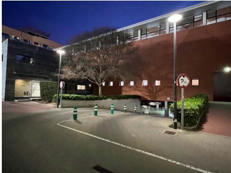
Figura 5.18: Entrada del aparcamiento.
