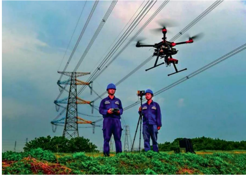
Figura 2.2: Operarios revisando cableado con drone.
