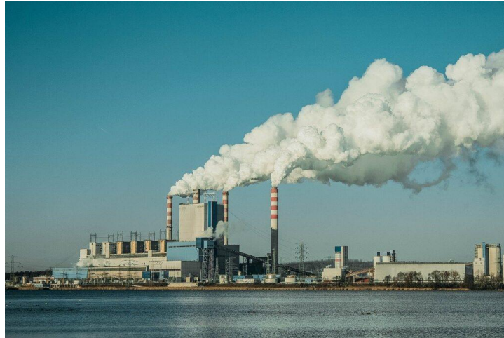
Figura 6.2: Emisiones en planta industrial.
