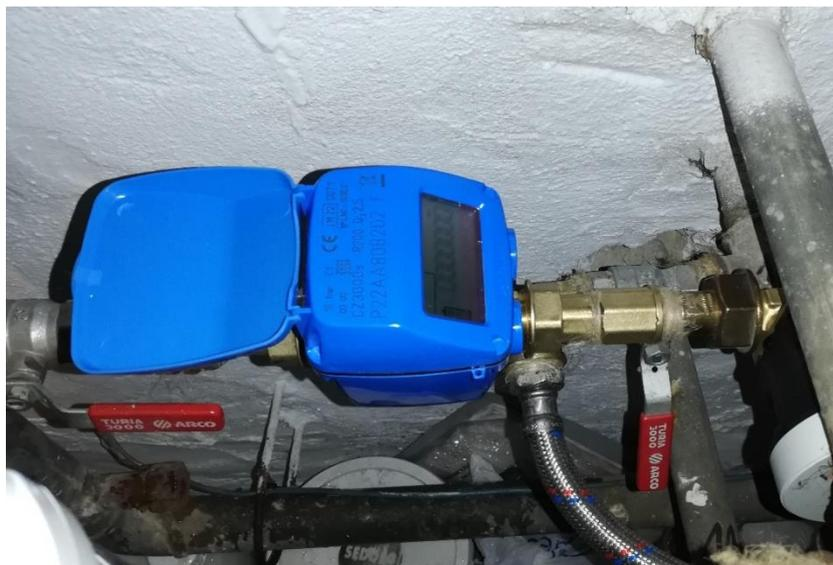
**Figura 9** Contador mecánico instalados en las viviendas. Fuente: (elaboración propia).
