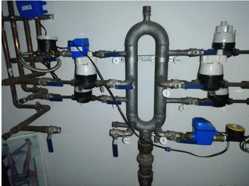
**Figura 11** Red y dispositivo de telelectura vía radio. Fuente: (Elaboración propia).
