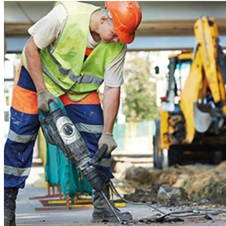
Figura 11 – Vibraciones en sistema mano-brazo: albañil sometido a las vibraciones de un taladro [14].
