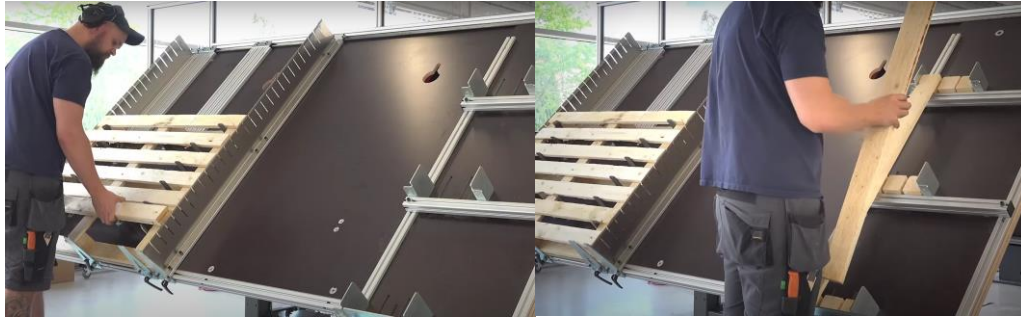
Ilustración 2. Posicionado de tablas y tacos de pallet en RN4017
