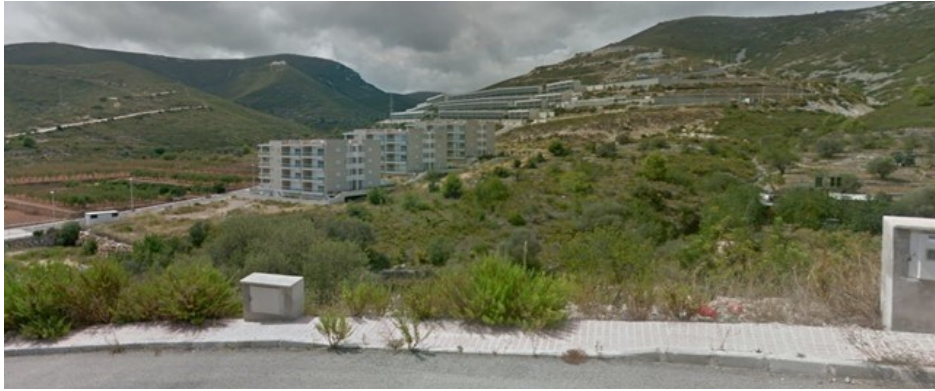
Imagen 30. URBANIZACIÓN EN PARQUE NATURAL.
