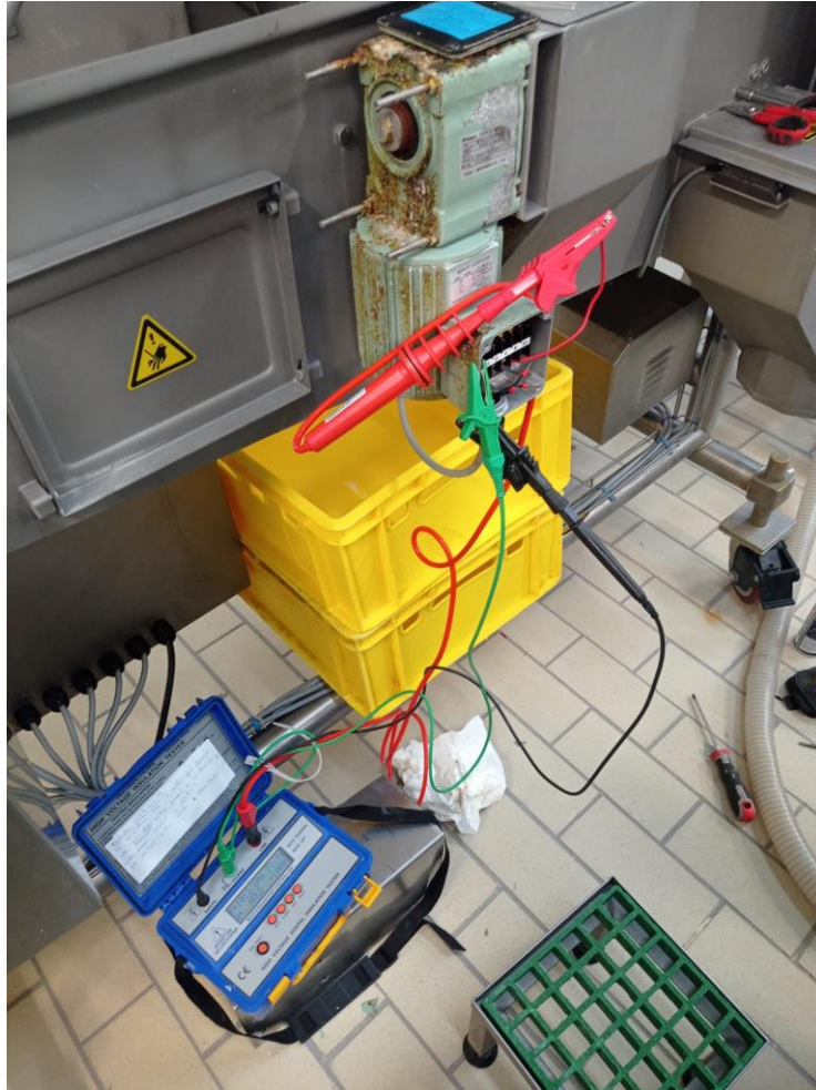
Figura 66: Ejecución de ensayos de medidas de resistencia de aislamiento en motor TSUBAKI
