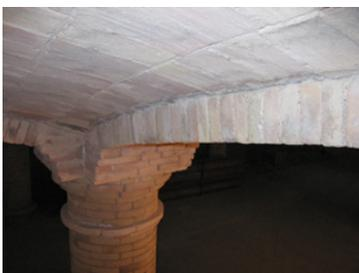
Imagen 4. Detalle de Bóveda-Arco-Pilar
