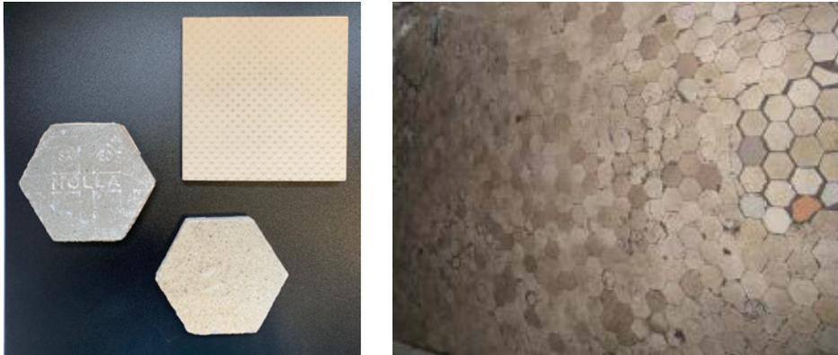
Imagen 5 y 6. Gres Nolla hexagonal y pavimento abotonado pescadería
