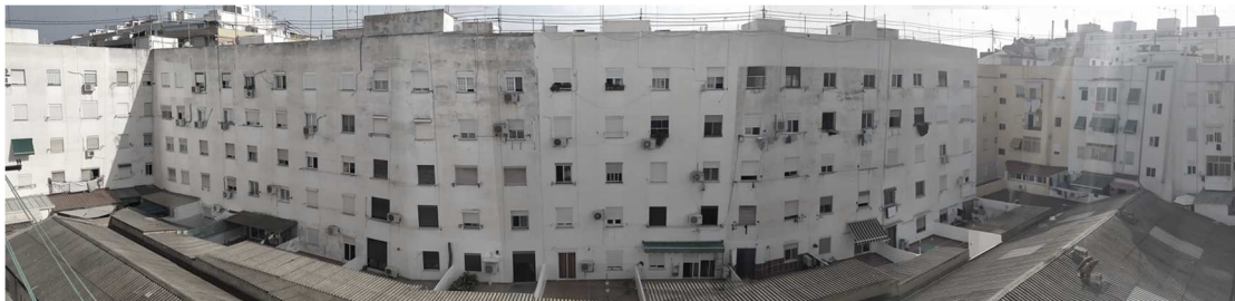
Imagen 40 - Vista a patio posterior. Edificio Caso de estudio
