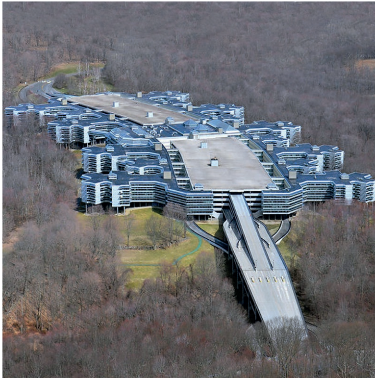
Figura 12. Acceso al interior de la Union Carbide mediante la subdivisión de la carretera de llegada.
