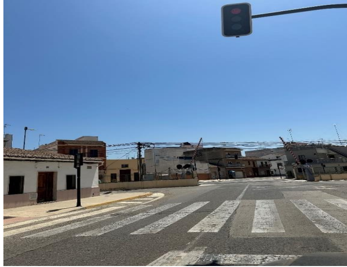
Fotografía 83: Paso a nivel calle Colón/ travesía CV-50.
