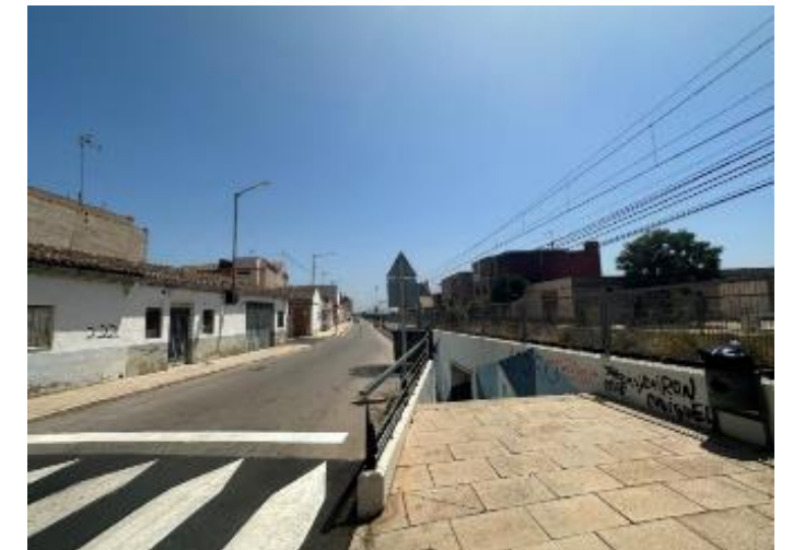
Fotografía 86: Paso inferior peatonal en la calle Ausiàs March.
