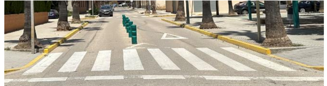
Fotografía 73: Adaptación acera al paso de peatones. Fuente: Elaboración propia.
