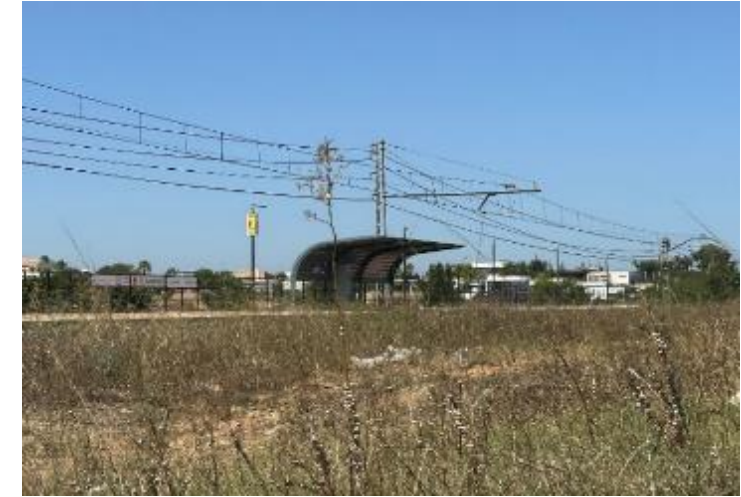
Fotografía 78: Estación de Ausiàs March.
