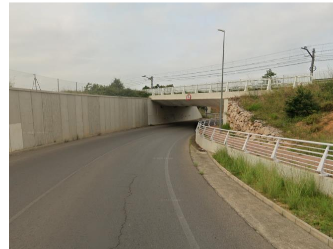
Fotografía 85: Paso inferior entre la Avenida Llaurador y la calle Carles Salvador.
