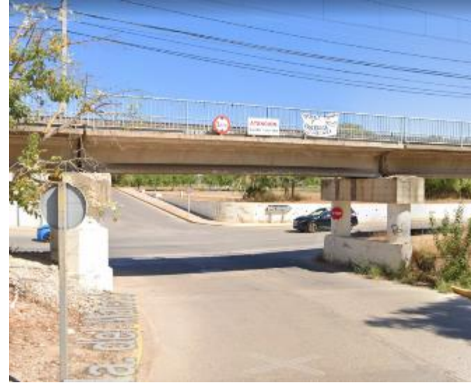
Fotografía 84: Paso inferior ronda del Malecón.
