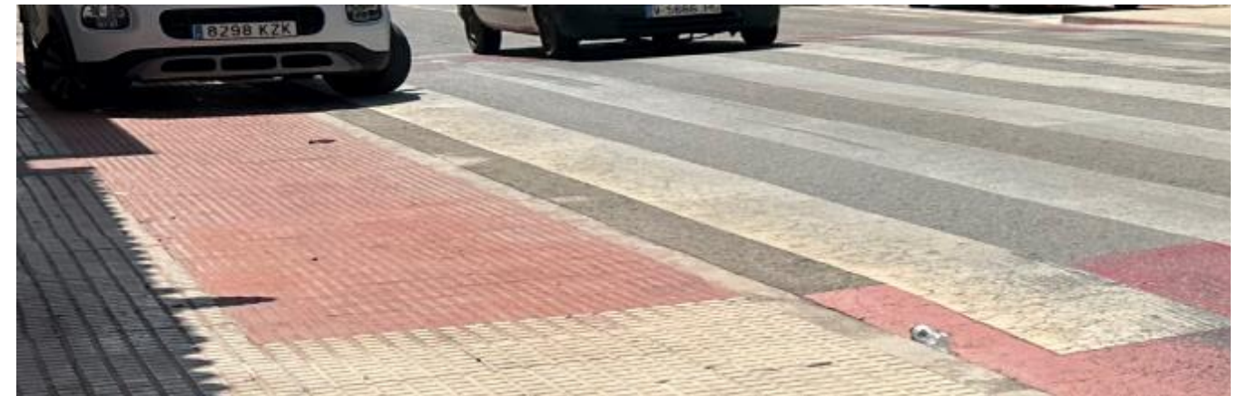
Fotografía 74: Adaptación paso de peatones sobre elevado a la altura de la acera. Fuente: Elaboración Propia.
