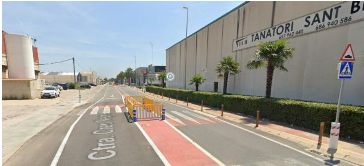
Fotografía 107: Paso de peatones con escalonado con isleta en la “Crta. de la Creu Negra”. Fuente: Google Maps.
