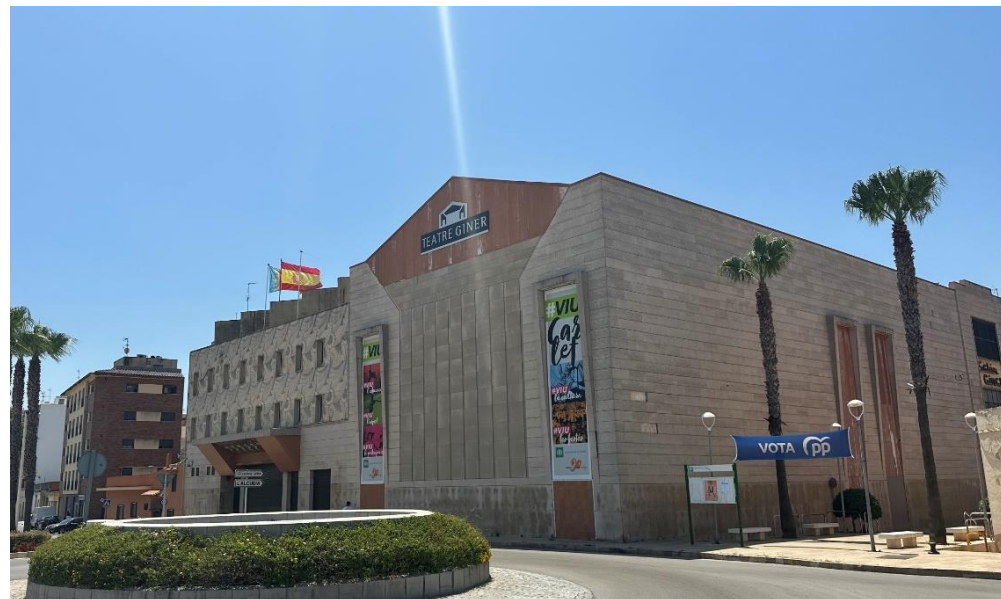
Fotografía 41: Teatro Giner. Fuente: Elaboración propia.
