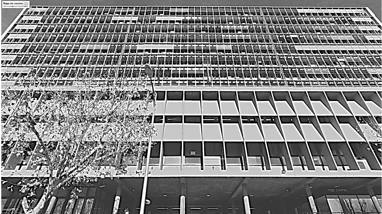
Fig. 12. Fachada Sur. Lamas horizontales. Facultad de Ciencias Geológicas y Biológicas.
