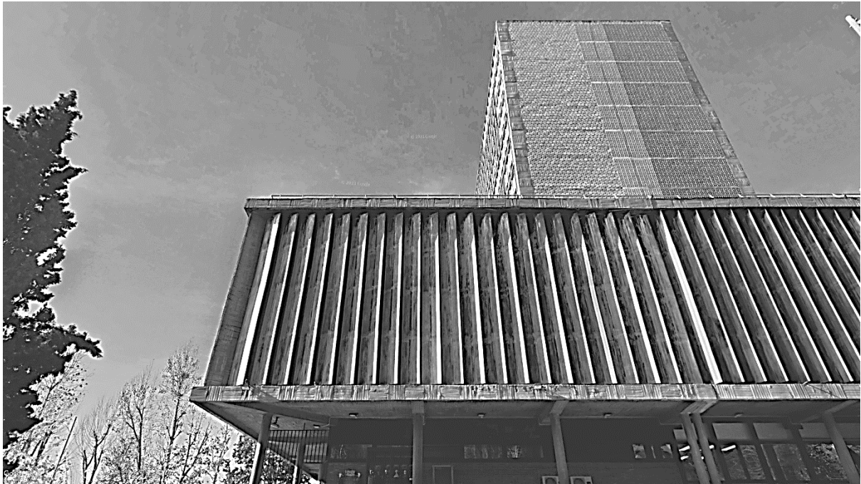
Fig. 14. Fachada Este. Lamas Verticales. Facultad de Ciencias Geológicas y Biológicas.
