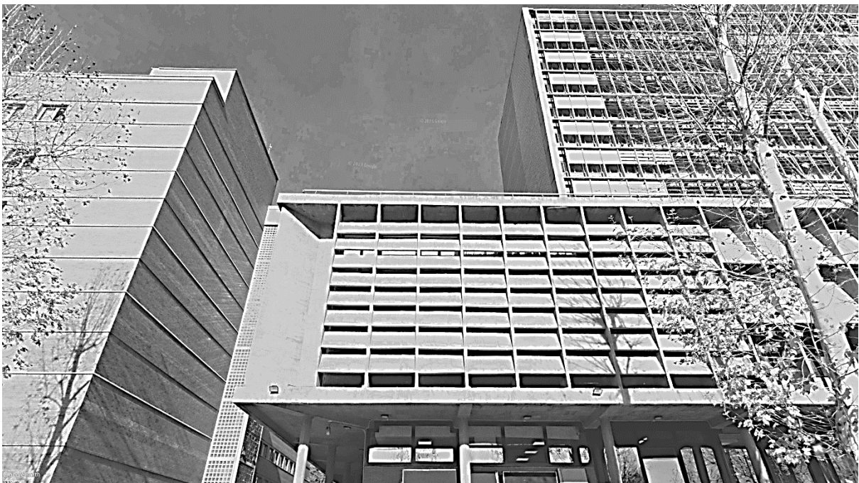
Fig. 13. Fachada Sur. Lamas horizontales. Facultad de Ciencias Geológicas y Biológicas.
