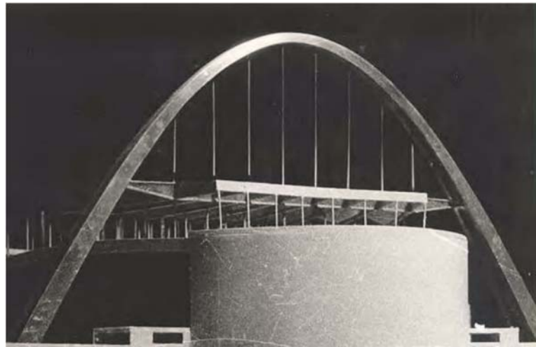
03. 53 Freyssinet. Hangares de Orly en construcción (1921-23). © L'Esprit Nouveau nº18 p.40 (1921) Publicad por Le Corbusier
