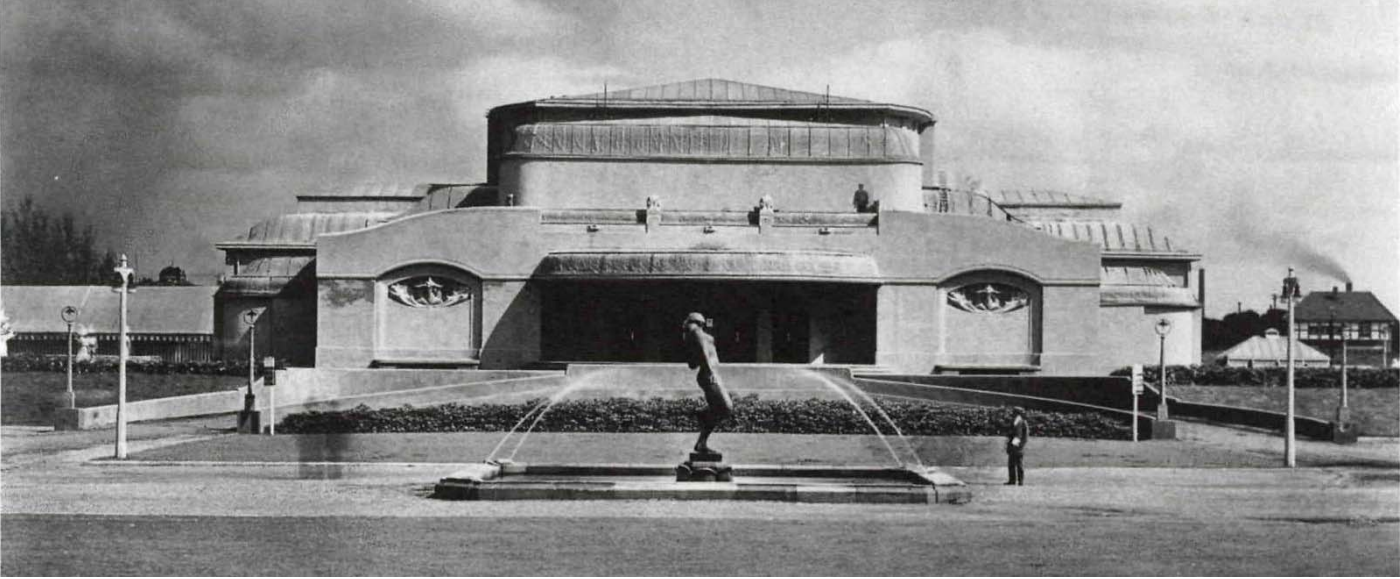
02. 38 Van de Velde. Teatro Werkbund, Colonia (1914). Fachada principal © Bildarchiv Foto Marburg
