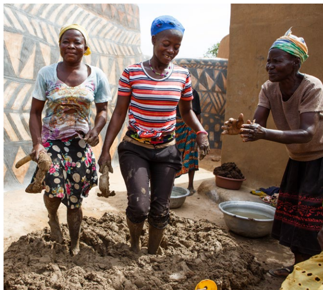
Des femmes kassena piétinent la terre avec leurs pieds pour effectuer les travaux d'entretien.
