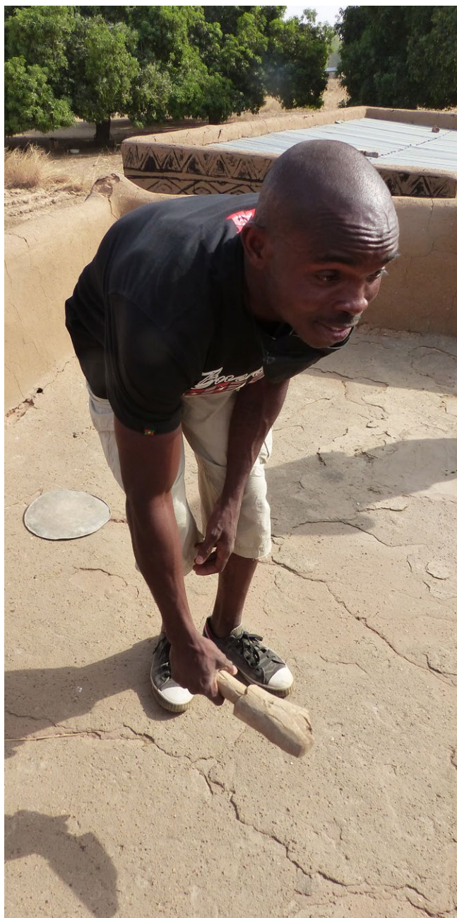
Exemple du système de tassement de la terre sur les toits-terrasse des habitations kassena lors de leur réparation à l'aide d'un pilon.
