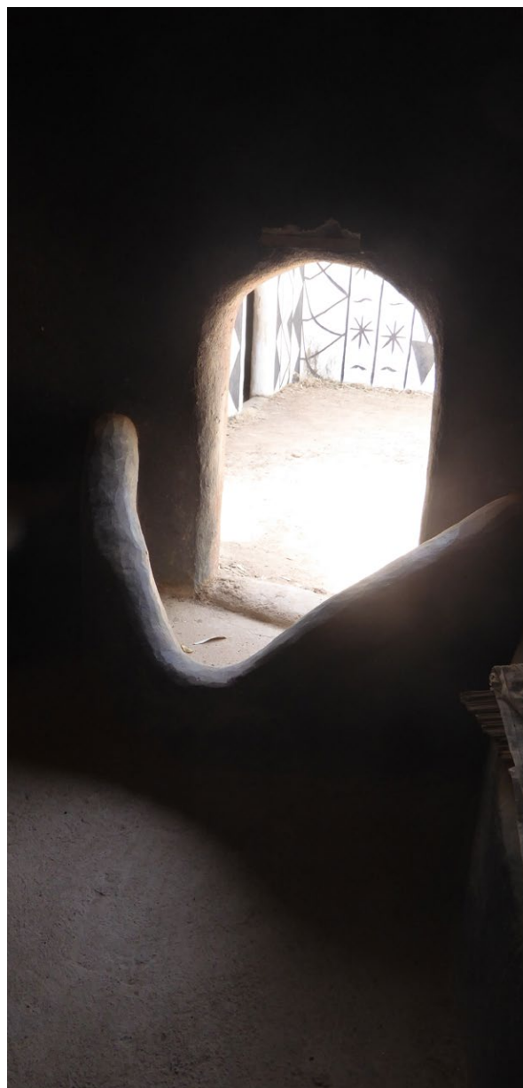
Seuil. Entrée d'une habitation kassena photographiée de l'intérieur, avec sa petite entrée et le muret avec une césure qui oblige à franchir le seuil en s'accroupissant et en levant en même temps les pieds.
