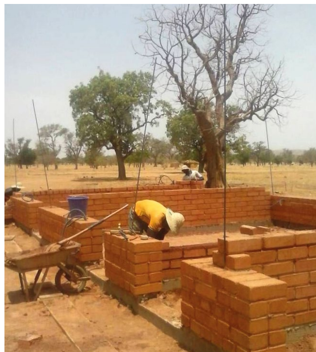
Construction de murs avec des blocs de terre compressée avec une armature faite de barres d'acier pour les chaînages verticaux à l'intersection des murs et les jambages .
