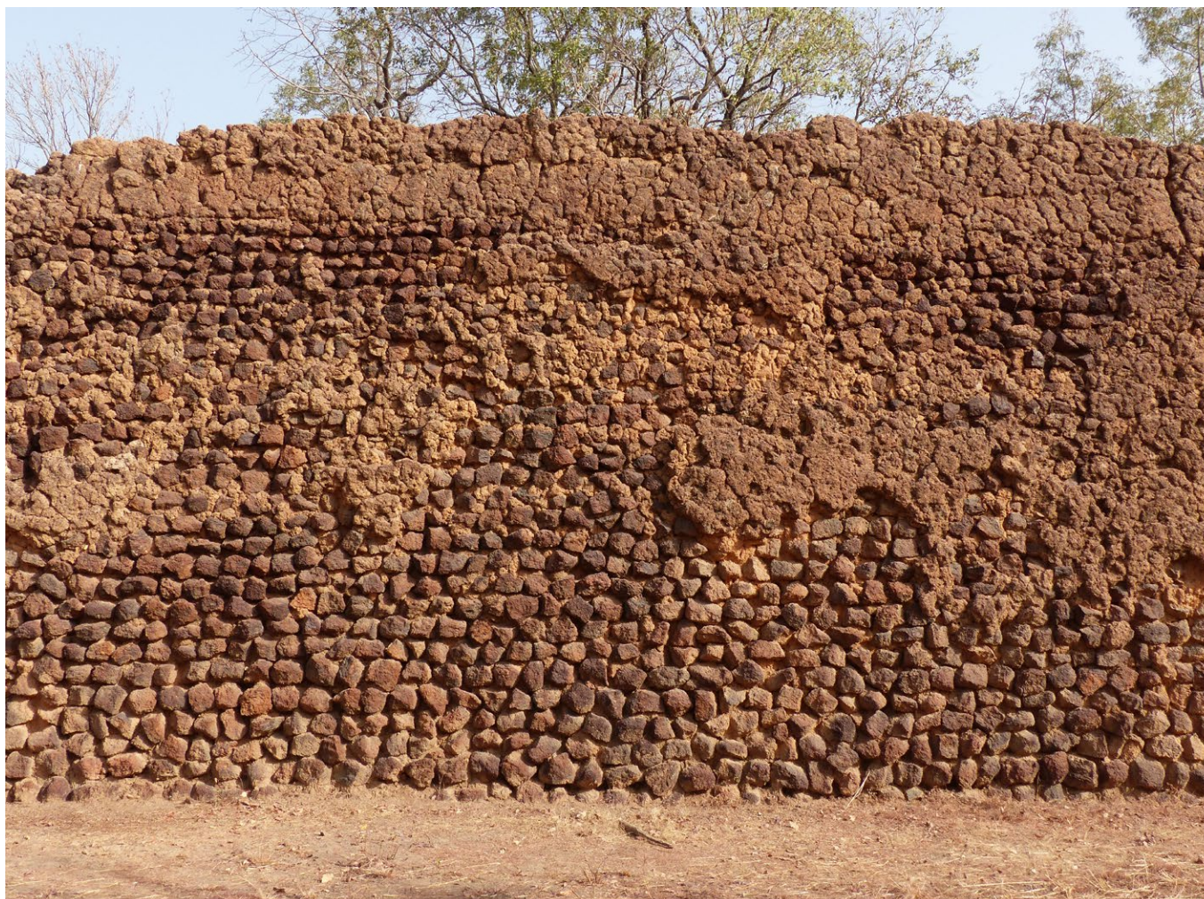
Mur en maçonnerie de latérite à Loropeni.
