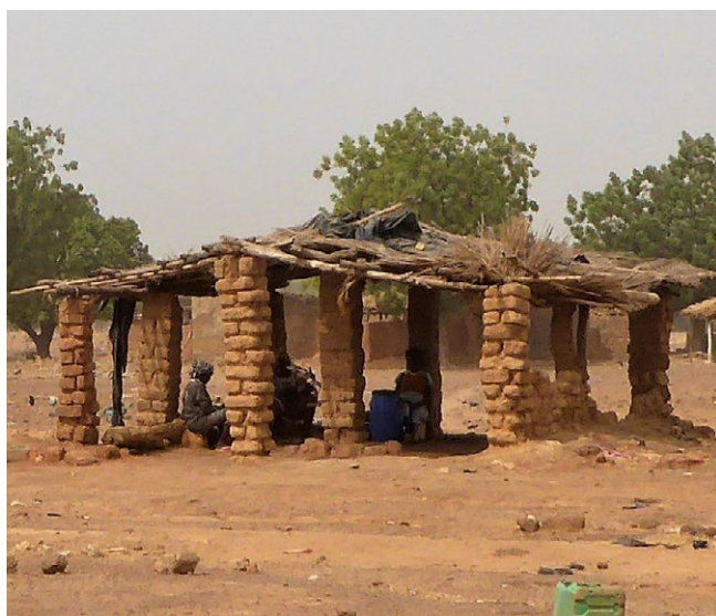
Abri rare sur des piliers en adobe et toiture à deux versants dans les environs de Koudougou.
