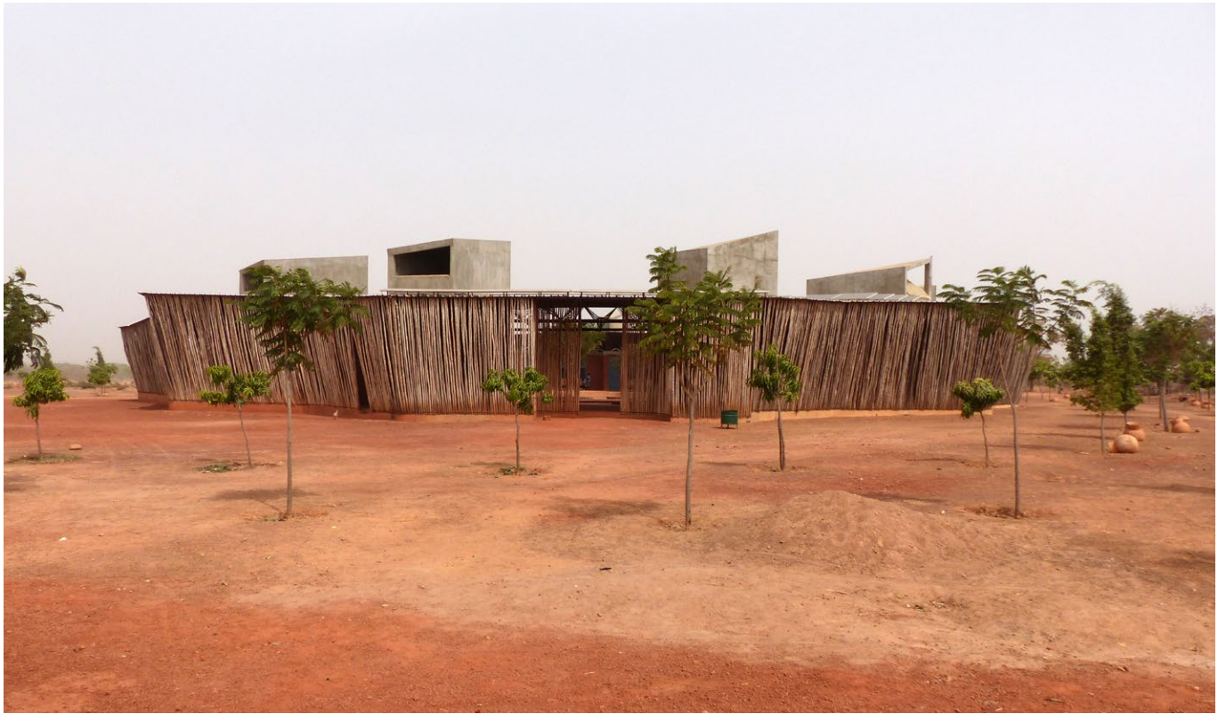
Lycée Schorge à Koudougou, conçu par Francis Kéré.
