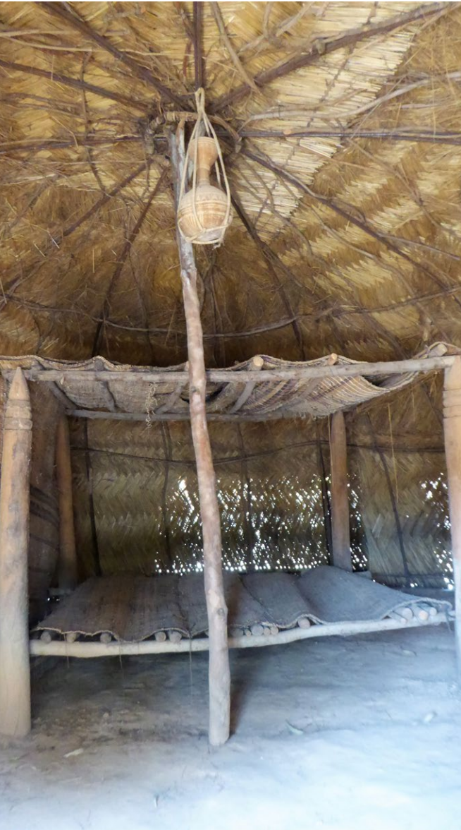
Intérieur de l'habitation peule exposée au Musée de Manega, avec le poteau central polyfurqué supportant la toiture et la plateforme du lit.
