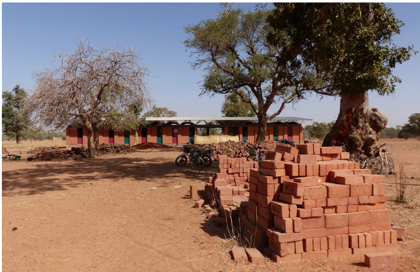
BTC stockée devant l'école pour les prochaines phases de construction.
