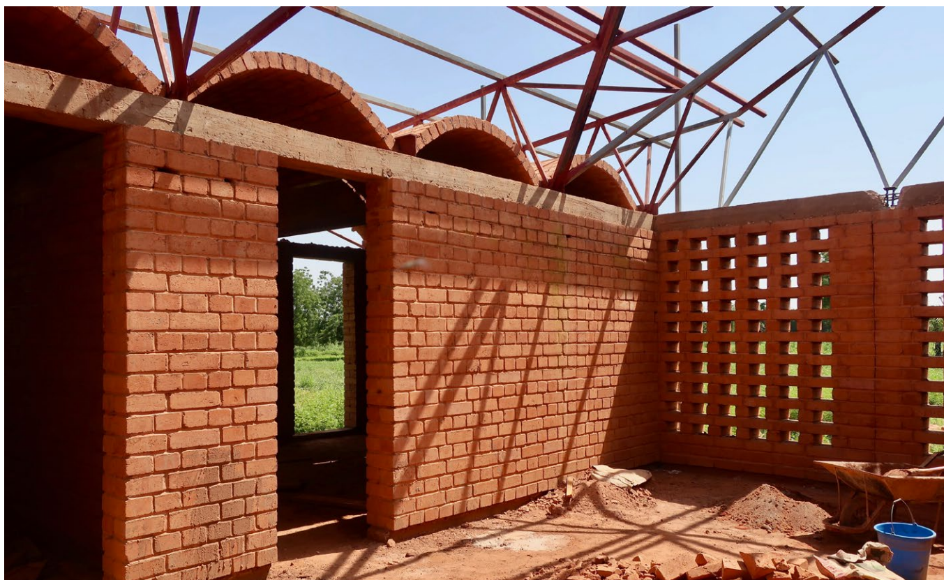
Intérieur du bâtiment administratif en construction, Phase 2 du projet.
