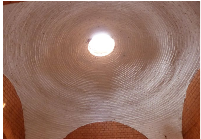
Les voûtes de BTC dans le marché de Koudougou.
