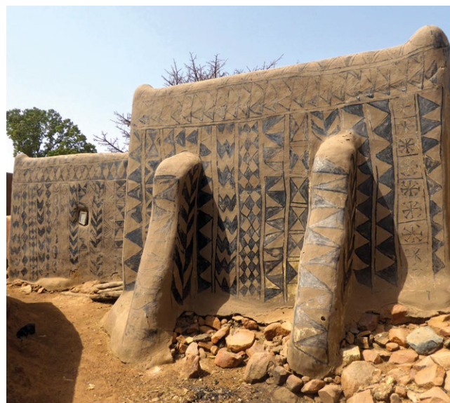
Mur d'une habitation kassena avec des contreforts
