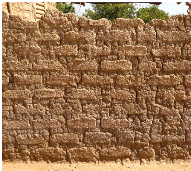
Maçonnerie d'adobes posée à l'aide de mortier de boue.
