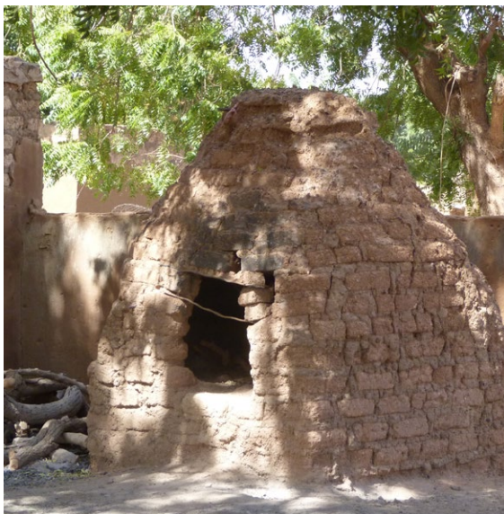
Four à pain avec voûte en arc-de-cloître pointu et tronqué au sommet.
