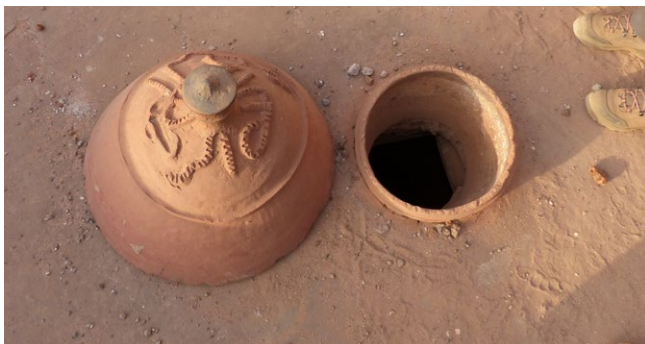
Oculus d'éclairage et de ventilation dans la mosquée de Bobo-Dioulasso avec sa cloche de couverture en céramique.
