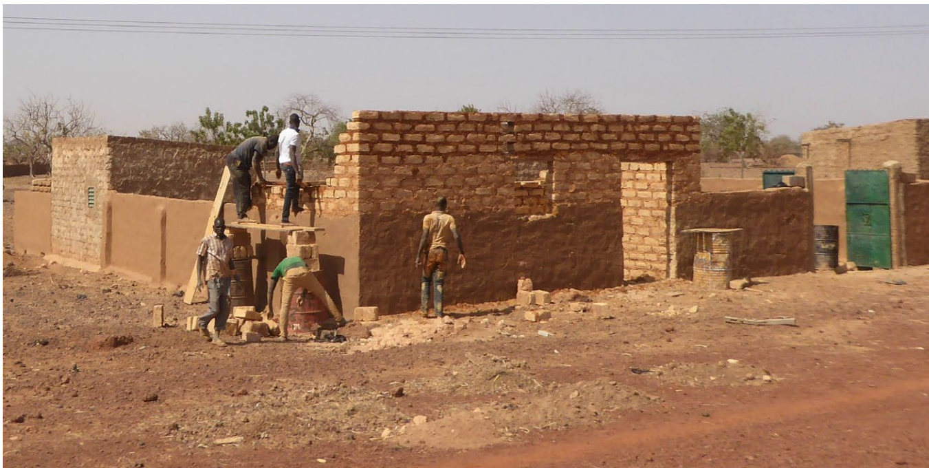
Construction d'une habitation avec des adobes.
