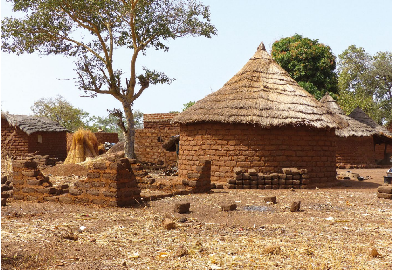
Case rectangulaire en construction à côté d'une case circulaire dans un village gan.
