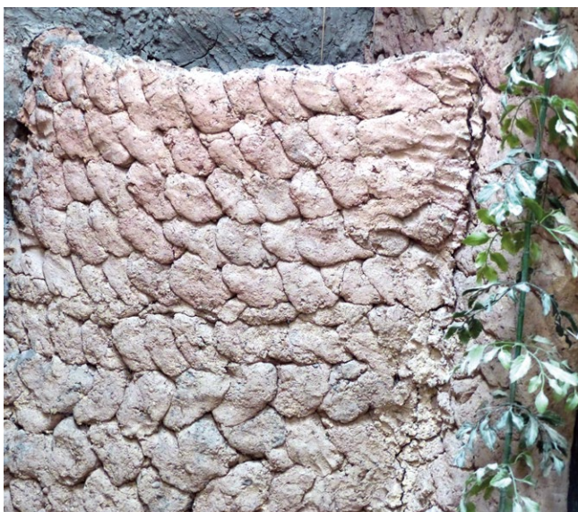
Le mur de glèbes est posé sans mortier de liaison car il est fraîchement monté.
