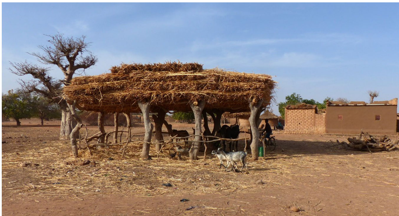
Abri avec de la paille entreposée en couches croisées sur la toiture utilisé également comme enclos pour les chèvres.
