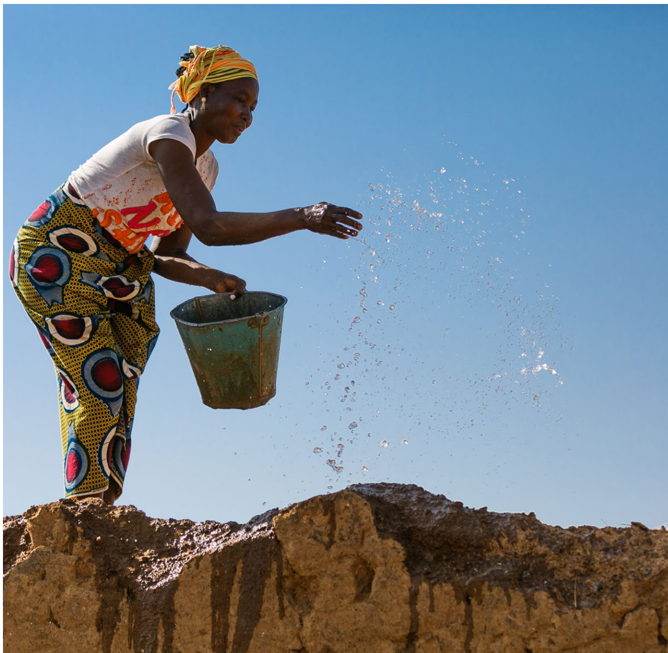
Une femme kassena arrose le toit-terrasse avant sa réparation.
