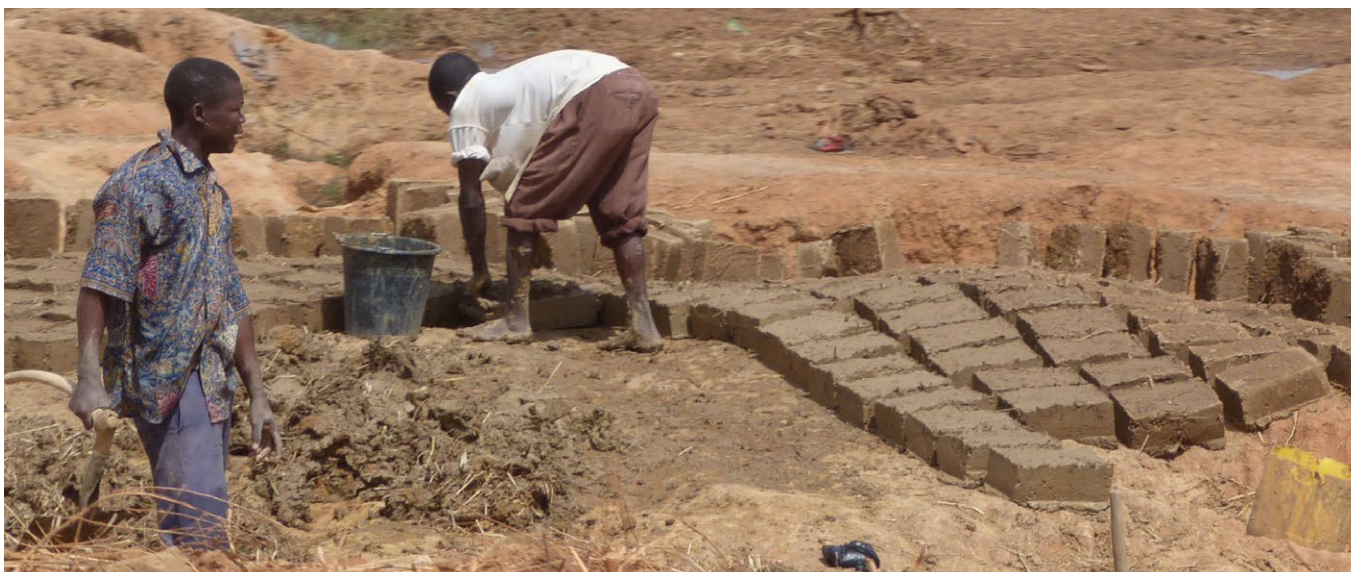
Fabrication d'adobes, l'un des matériaux de construction actuellement utilisés dans les zones rurales du Burkina Faso.
