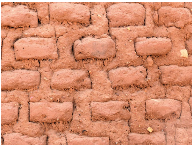
Mur hybride entre mur en bauge et mur en adobe à la Cour royale de Tiébélé
