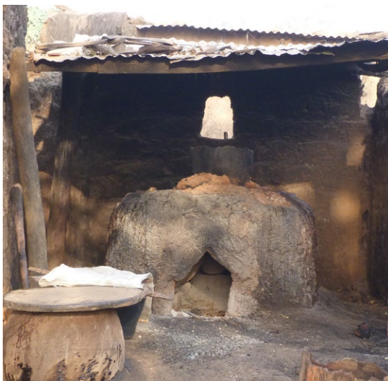
Four à pain avec une voûte abaissée sur laquelle le pain peut éventuellement être posé grâce au toit de protection qui permet de ne pas se soucier des problèmes d'évacuation de l'eau.
