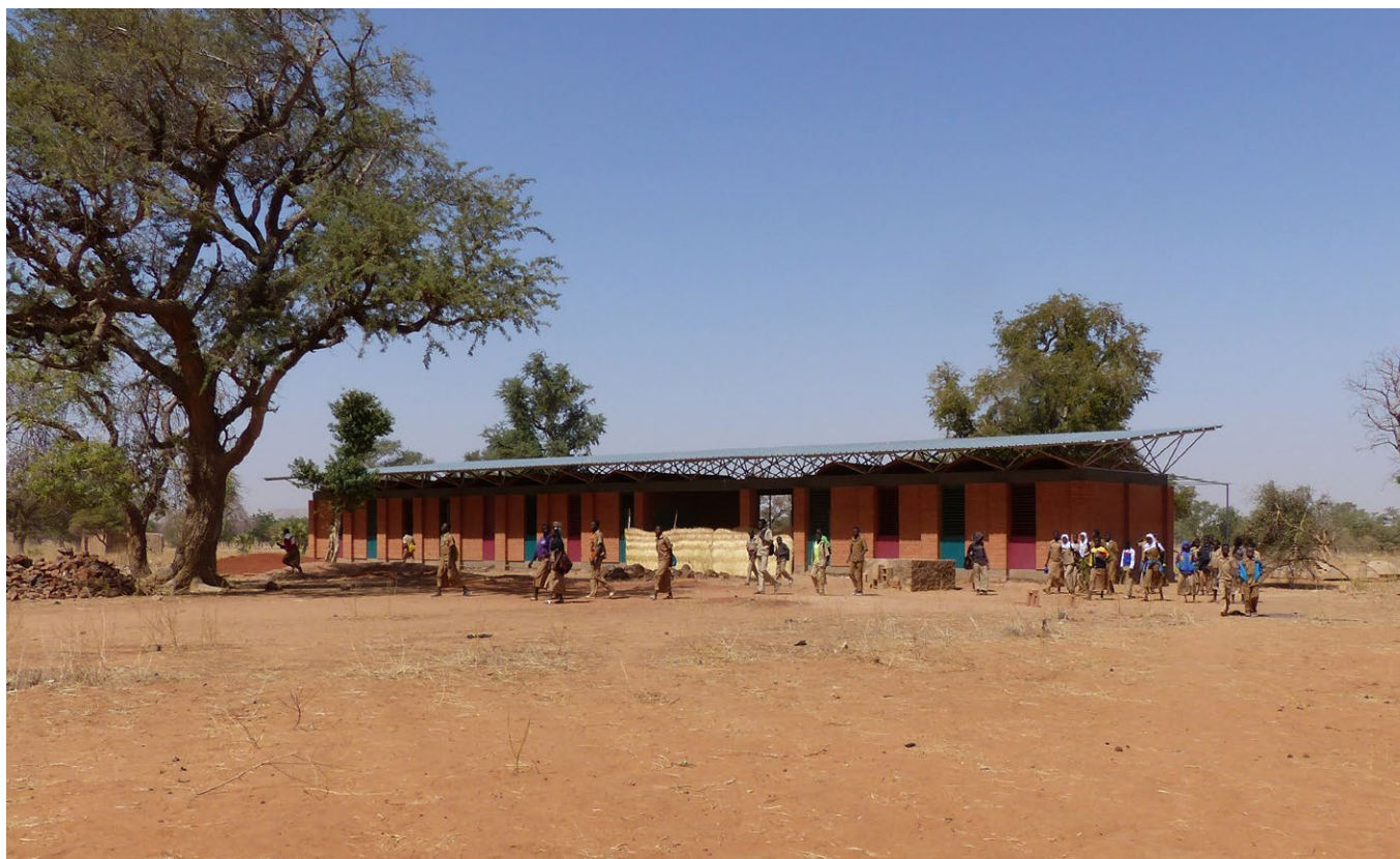
Salles de classe de l'école, construites durant la phase 1 du projet.
