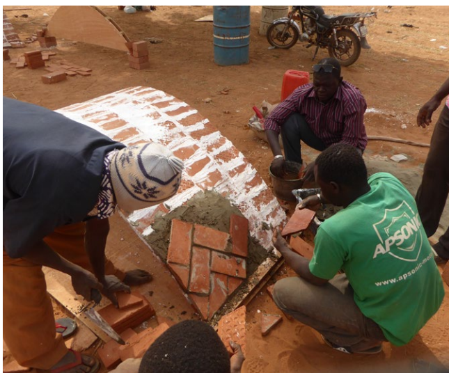
Atelier pour la construction de voûtes dans le village de Baasneere.
