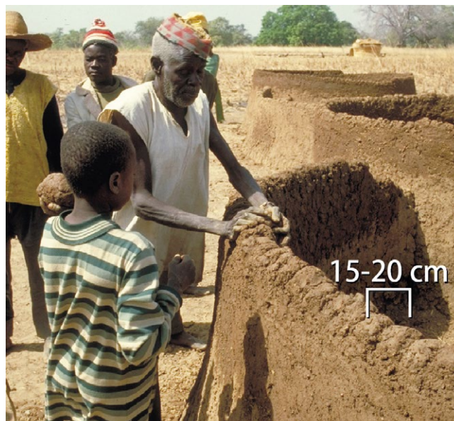
Construction d'un mur en terre de façonnage direct.
