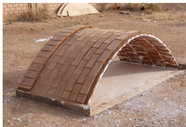
Une voûte de l'atelier de Ougadougou, une fois terminée.
